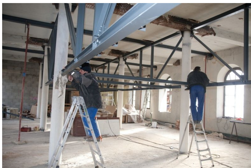
Photo 3.23. Vue sur les travaux de structure des lofts. (Source : www.domainedemontchal.com ).
