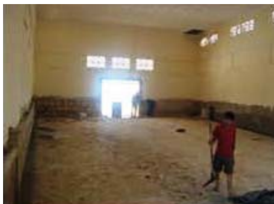
Photo 3.2. Etat de la cave pendant les travaux. (Source : K. Messaoudi).
