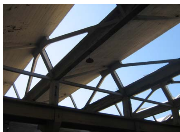
Photo 4.22. Structure de la couverture en sheds.
