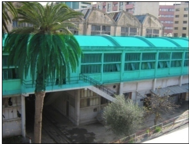
Figure 4.5. Vue générale sur le bloc A.
