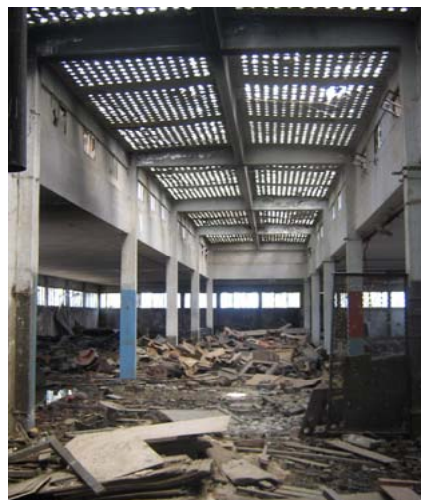
Photo 4.34. Vue sur la partie centrale du magasin des modèles et de
