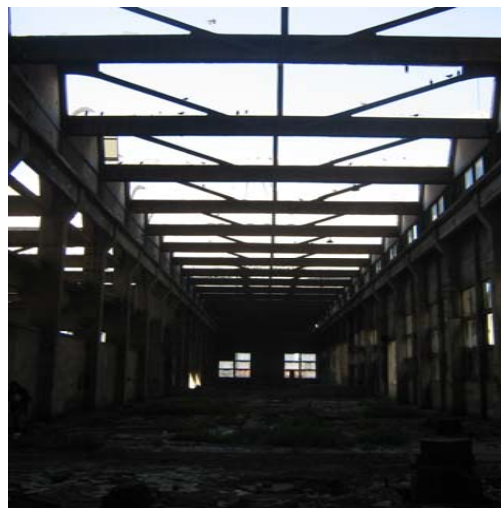
Photo 4.25. Partie réservée à la fonderie.
