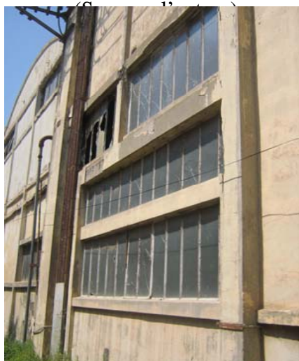
Photo 4.21. Vue sur la nature des ouvertures de la façade SUD. (Source : l'auteur).
