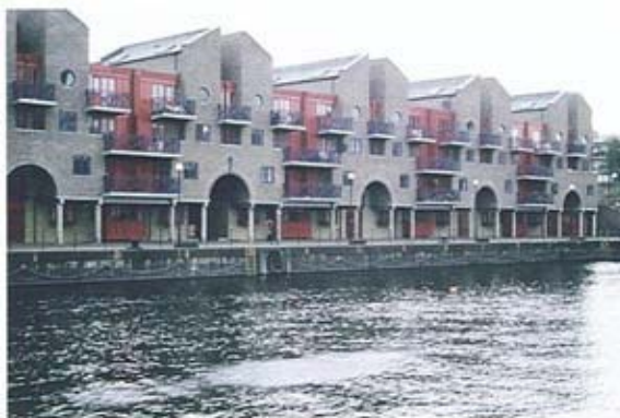
Photo 1.3. Réhabilitation des Royal Docks en logements.
