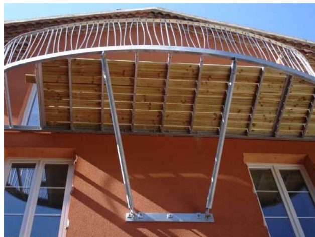
Photo 3.21. Vue sur un balcon inséré au deuxième étage du bâtiment C. (Source : www.domainedemontchal.com ).
