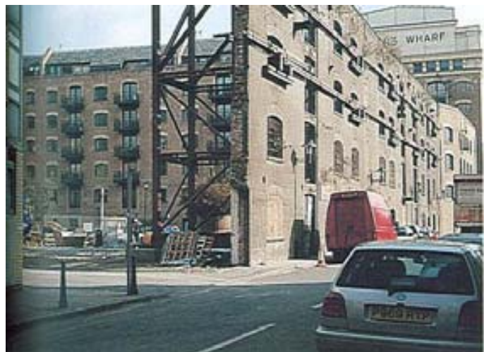
Photo1.2. "Façadisme" pour la réhabilitation d'un immeuble des docks en bureaux.
