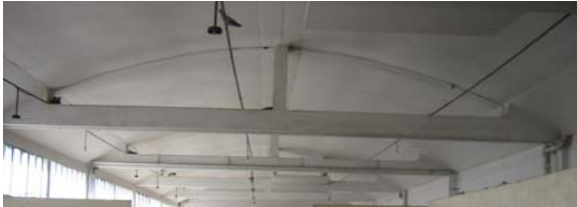
Photo 4.16. Vue intérieure de la couverture en voute des vestiaires. (Source : l'auteur).
