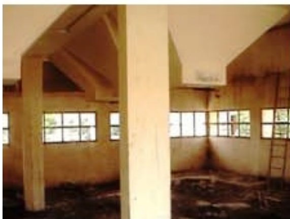
Photo 3.5. Vue intérieure sur les silos avant leur démolition. (Source : K. Messaoudi).
