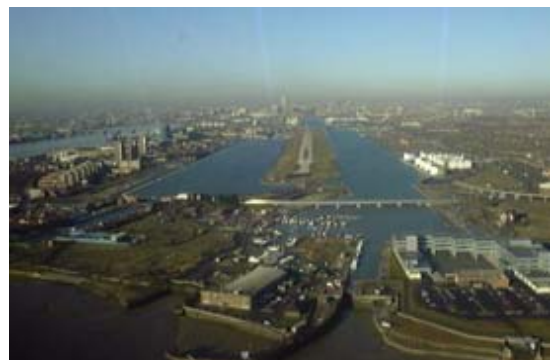
Photo 1.4. Vue globale sur la friche après réhabilitation.
