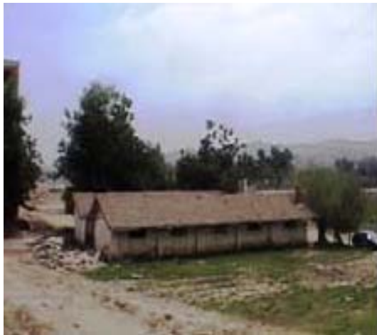
Photo 3.11. Vue sur les deux bâtiments de l'ancienne bergerie. (Source : K. Messaoudi).
