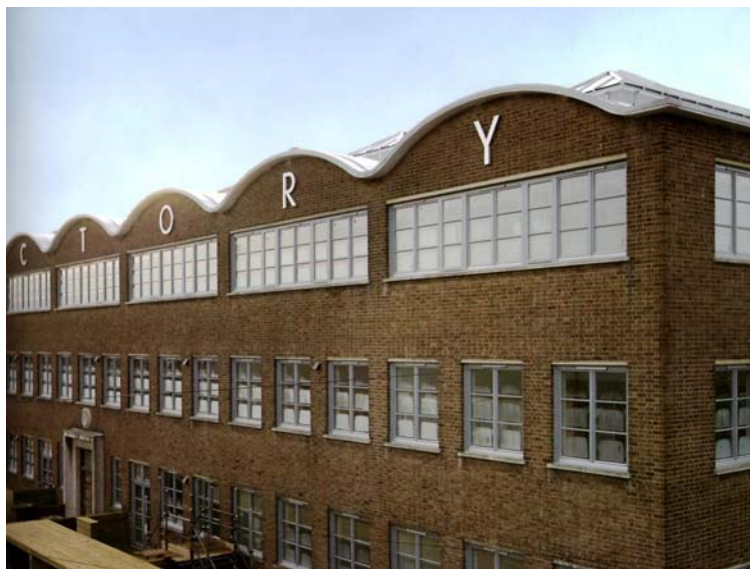
Photo 3.25. Vue sur la façade principale en travaux. (Source : Julio Fajardo, 2008.).
