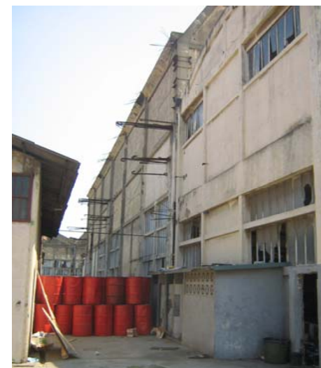
Photo 4.20. Façade Nord du bloc A.
