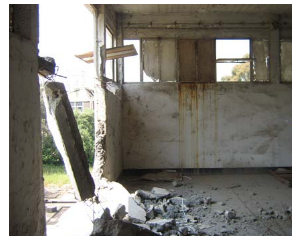
Photo 4.35. Vue sur le bureau de gestion.
