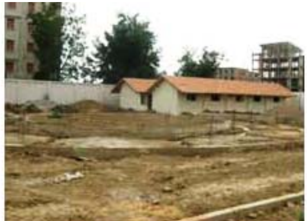
Photo 3.12. Vue sur la porcherie en cours de réhabilitation. (Source : K. Messaoudi).
