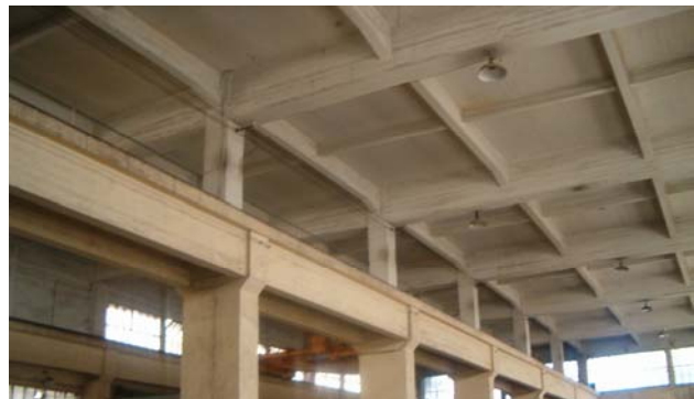
Photo 4.40. Plancher nervuré du bloc C. (Source : l'auteur).
