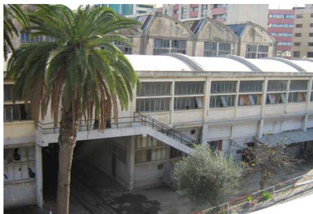
Photo 4.19. Façade EST du bloc A. (Source : l'auteur).
