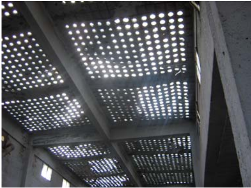
Photo 4.36. Vue sur le traitement de la couverture en béton et briques de verre. (Source : l'auteur).
