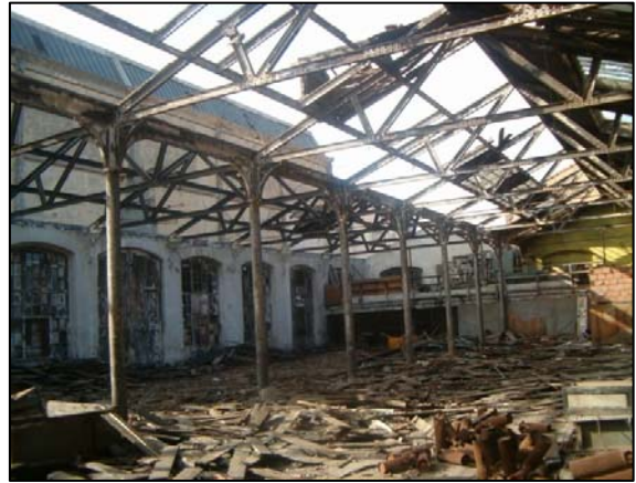
Photo 4.6. Vue du parc radiateur et batterie. (Bloc 1et2)
