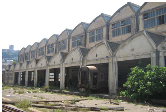
Photo 4.18. Façade EST du bloc A.
