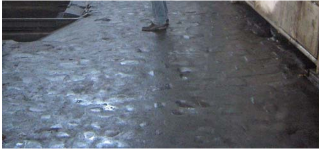
Photo 4.41. Salissures de graisse et d'huile de vidanges sur les planchers. (Source : l'auteur).
