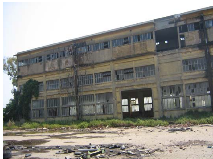
Photo 4.2. Vue générale sur le bloc C.
