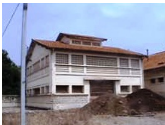
Photo 3.6. Vue extérieure des silos avant leur réhabilitation. (Source : K. Messaoudi).
