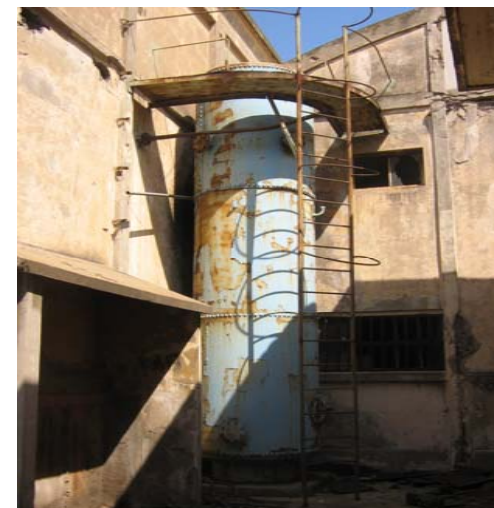
Photo 4.26. Emplacement de la citerne.
