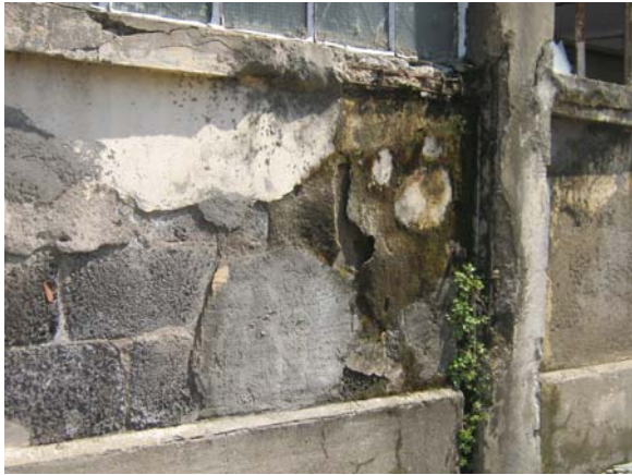
Photo 4.53. Prolifération de plantes à la base des parois humides du bloc B. (Source : l'auteur).
