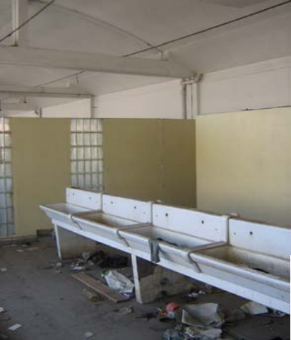
Photo 4.13. Vue sur l'un des boxes des vestiaires.
