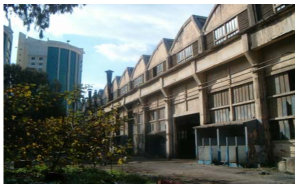
Photo 4.27. Façade EST du bloc B.
