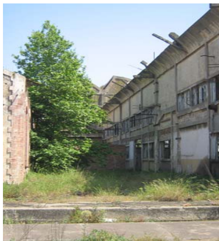
Photo 4.24. Façade NORD du bloc B.
