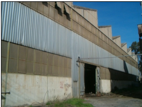
Photo 4.7. Vue sur le bâtiment des moteurs techniques. (Bloc 4).
