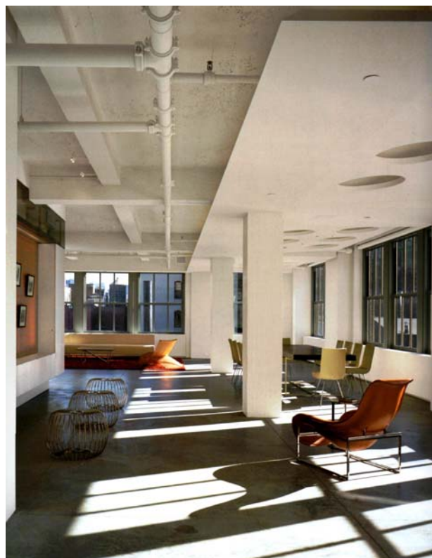
Photo 3.29. Vue sur le traitement des plafonds, entre abaissement et mise en avant des caractères constructifs originels. (Source : Julio Fajardo, 2008.).
