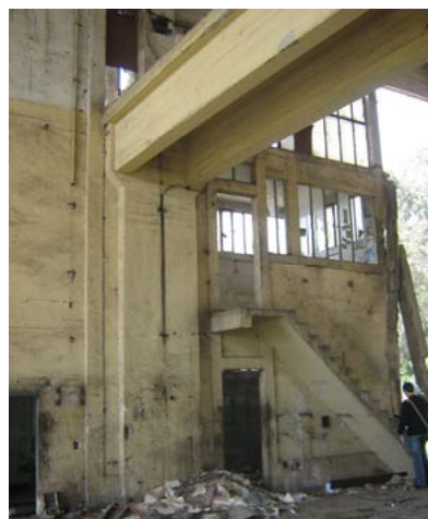
Photo 4.31. Vue sur le poste de surveillance.
