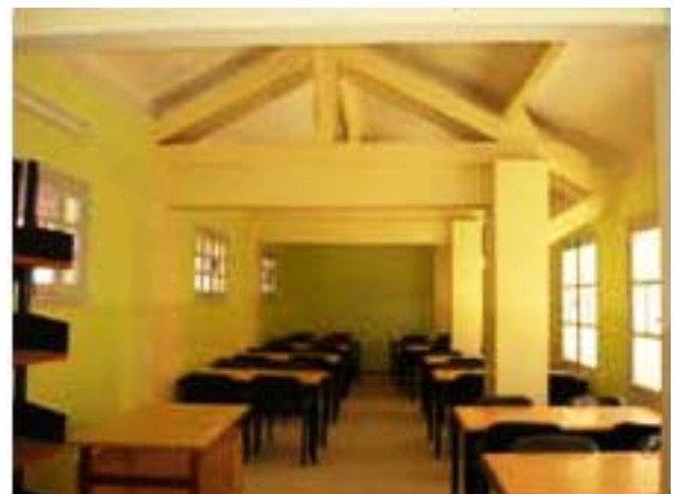
Photo 3.13. Vue sur la charpente réhabilitée. (Source : K. Messaoudi).
