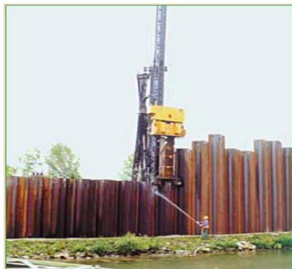
Fig. II.48. Chantier de battage.
