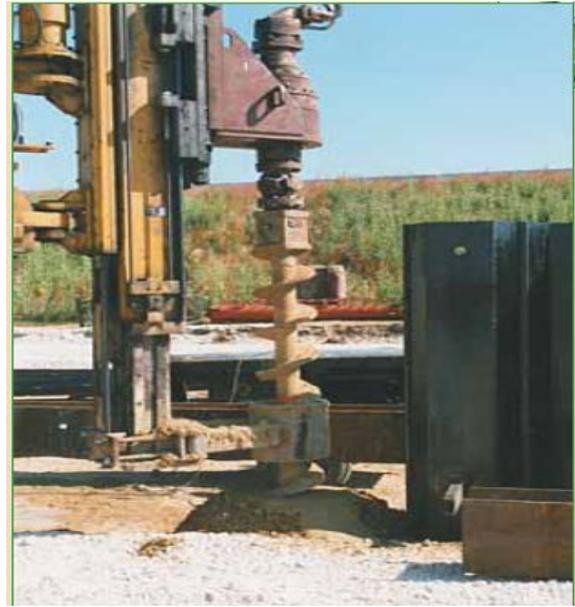
Fig. II.52. Perforage avant fonçage
