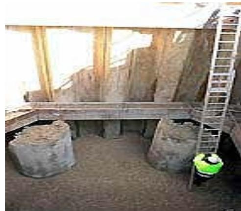
**Fig. II.41. Fouilles en présence de nappe.**
