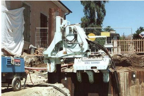
Fig. II.54. La presse hydraulique
