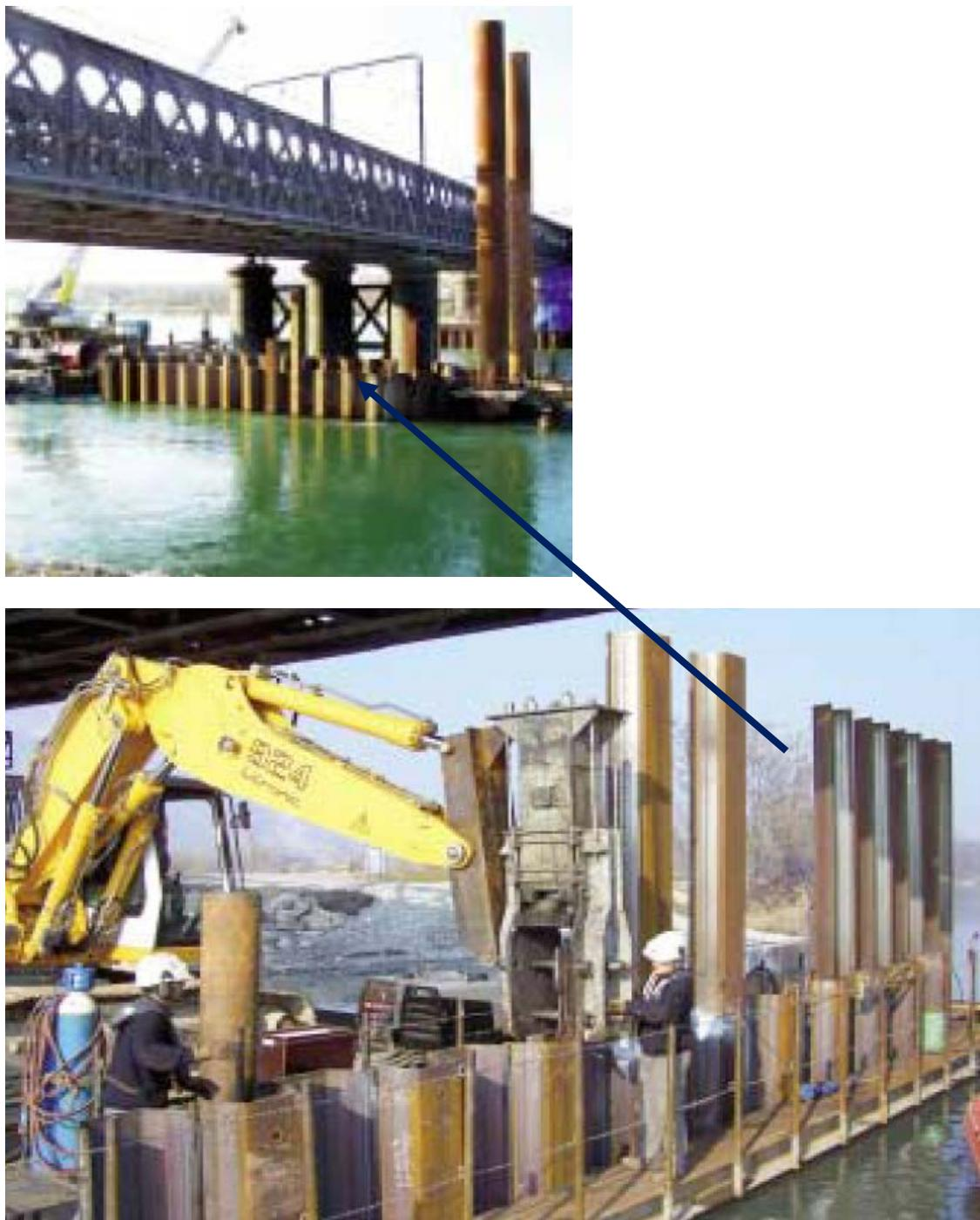
**Fig. II.46. Chantier d'une reconstruction d'un pont en utilisant des palplanches métalliques.**
