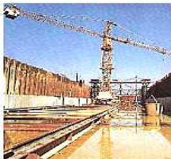
**Fig. II.36. L'utilisation des palplanches pour une écluse.**
