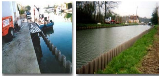
Fig. II.33.Exemple d'utilisation des palplanches en PVC.
