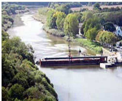
**Fig. II.38. L'utilisation des palplanches comme batardeaux en rivière.**
