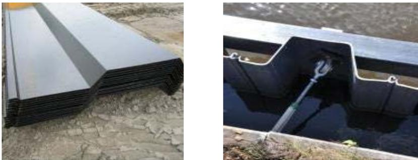
**Fig. II.7. Palplanches laminées à froid.**
