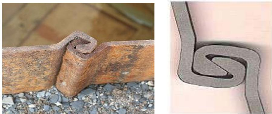
Fig. II.19. Serrure à la jonction de deux palplanches.
