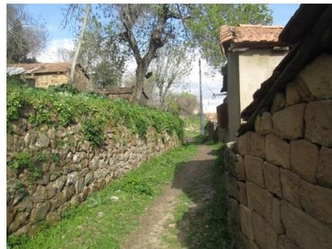
**Figure V.19** : Mur de soutènement en pierre sèche.
