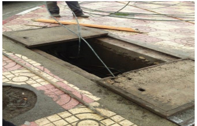
Figure 10 : Pose de câble fibre optique
