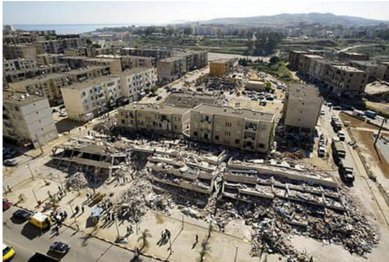
Figure 21 : Cité 11 Décembre. Effondrement des bâtiments suit au séisme Mai 2003. Source : Internet
