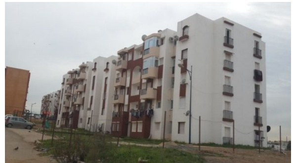
Figure 38: construction de nouveaux bâtiments Source : Auteurs
