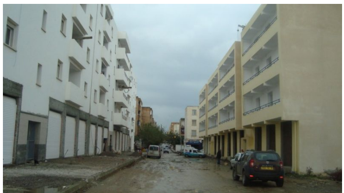
Figure 23 : Reconstruction des bâtiments effondrés Source : Auteurs
