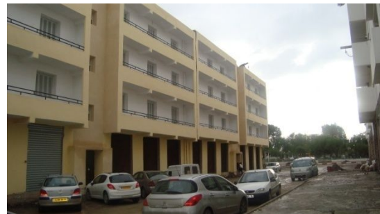
Figure 28 : Cité 11 Décembre Source : Auteurs
