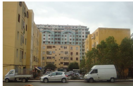
Figure 20 : cité 11 décembre Source : Auteurs
