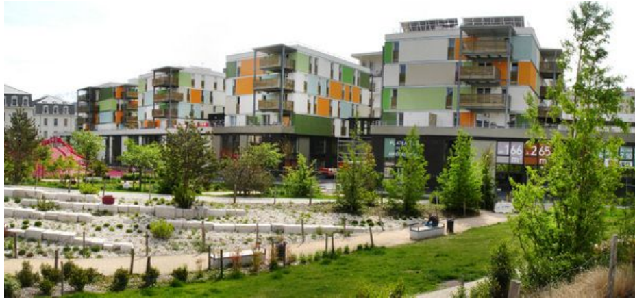
Figure 04 : éco-quartier de la ZAC de Bonne à Grenoble en France
