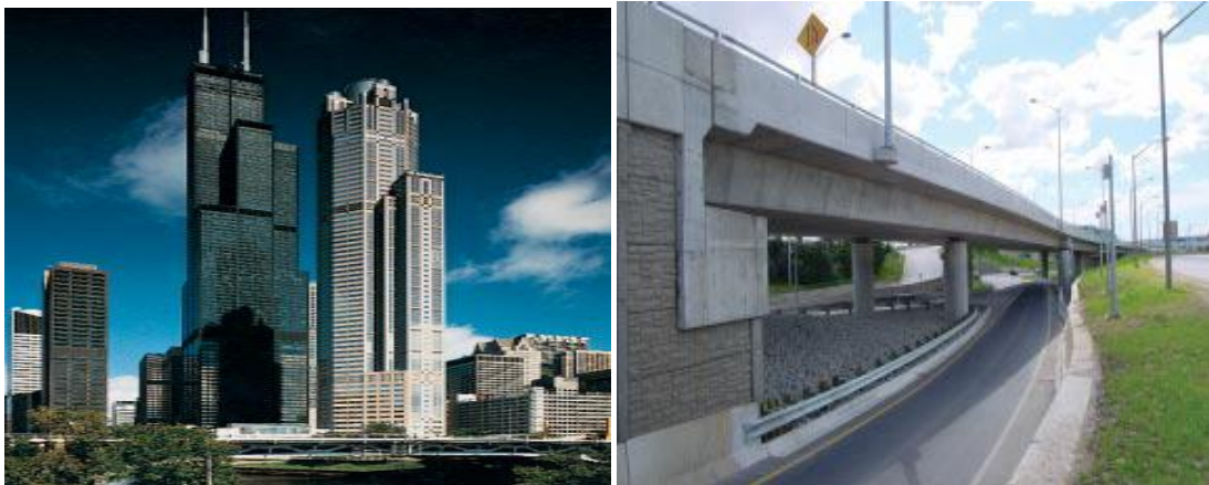
Figure 1. Le béton à hautes performances est fréquemment employé dans la construction de ponts (droite) ou de bâtiments multi étagés (gauche) [4]
