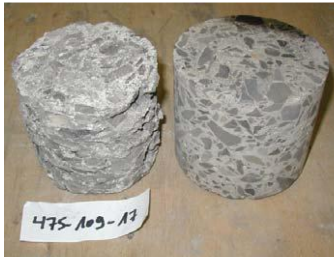
Figure 34. Carotte de béton (320 kg/m 3 de ciment CEM I 42,5 R, E/C 0,5) soumise pendant 27 jours à des cycles d'attaque à l'acide acétique (pH 4- 4,5). A titre de comparaison, à droite, une carotte de béton identique, non soumise aux essais [83]
