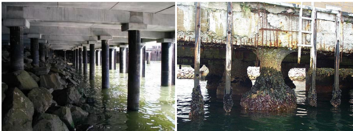
Figure 41. Etat des éléments en béton soumis à l'attaque par l'eau de mer [90]
