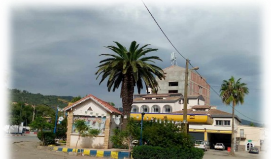
Figure 67: parois nord de boulevard Chabane Ahcene Source : Auteurs.
