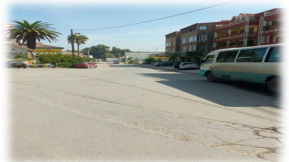
Figure 68: Photo de paroi sud de boulevard Chabane Ahcene.
