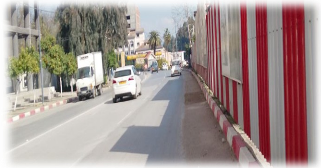
Figure 58: La paroi sud de deuxième tronçon de l'avenue Chabane Ahcene. Source : Auteurs.
