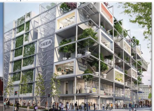
Figure 95: Mixité verticale - Commerce de grande surface et bureaux.
