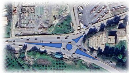
Figure 31: Image Aérienne de nœud Chabane Ahcene. Source : Google Earth 08/11/2024 Traité par auteurs
