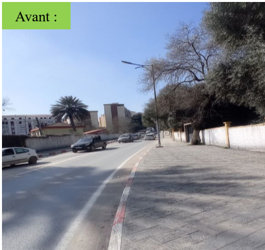
Figure 139: image de rue Mellouli Ahmed avant l'intervention.
