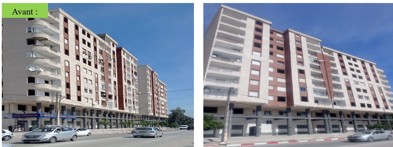
Figure 147: image de la façade de bâtiment Azlef avant l'intervention.
