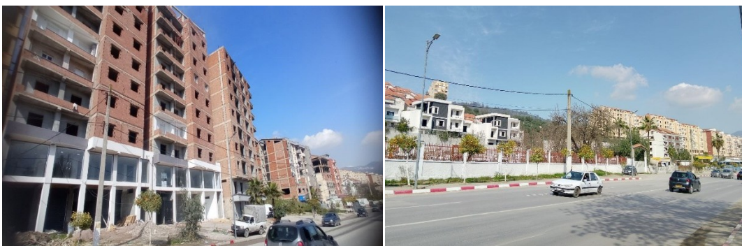
Figure 52: La paroi nord de l'avenue Chabane Ahcene. Source : Auteurs
