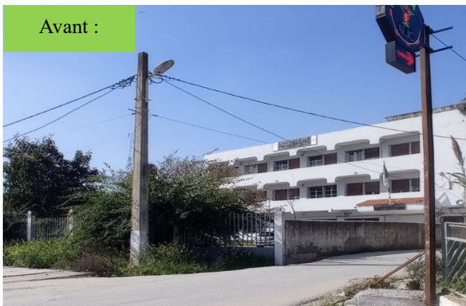
Figure 154: Image de l'inspection de travail avant l'intervention.
