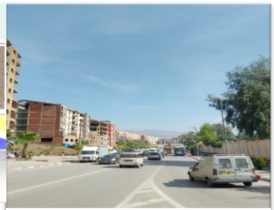
Figure 55: Image de premier tronçon de l'avenue Chabane Ahcene.
