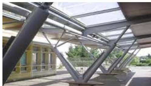
Figure 205: photo des poteaux métalliques.
