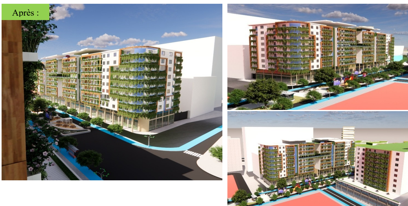
Figure 146: image de façade bâtiment Azlef après l'intervention
