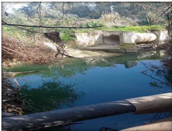
Figure 44: photo d'oued de l'habitat. Source : Auteures 2024
