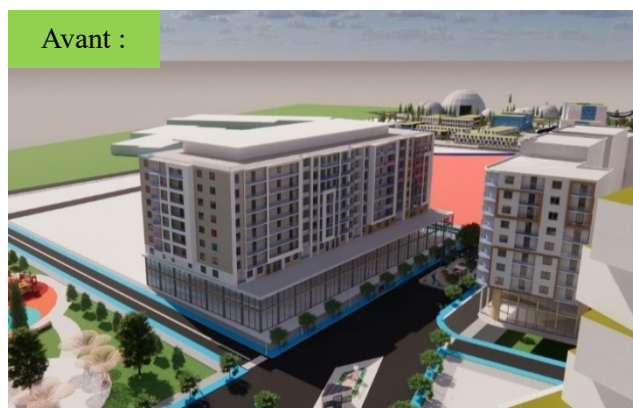
Figure 149: image bâtiment citronnier avant l'intervention.
