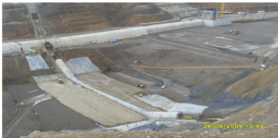
Figure V.6. Stabilisation par compactage de surface
