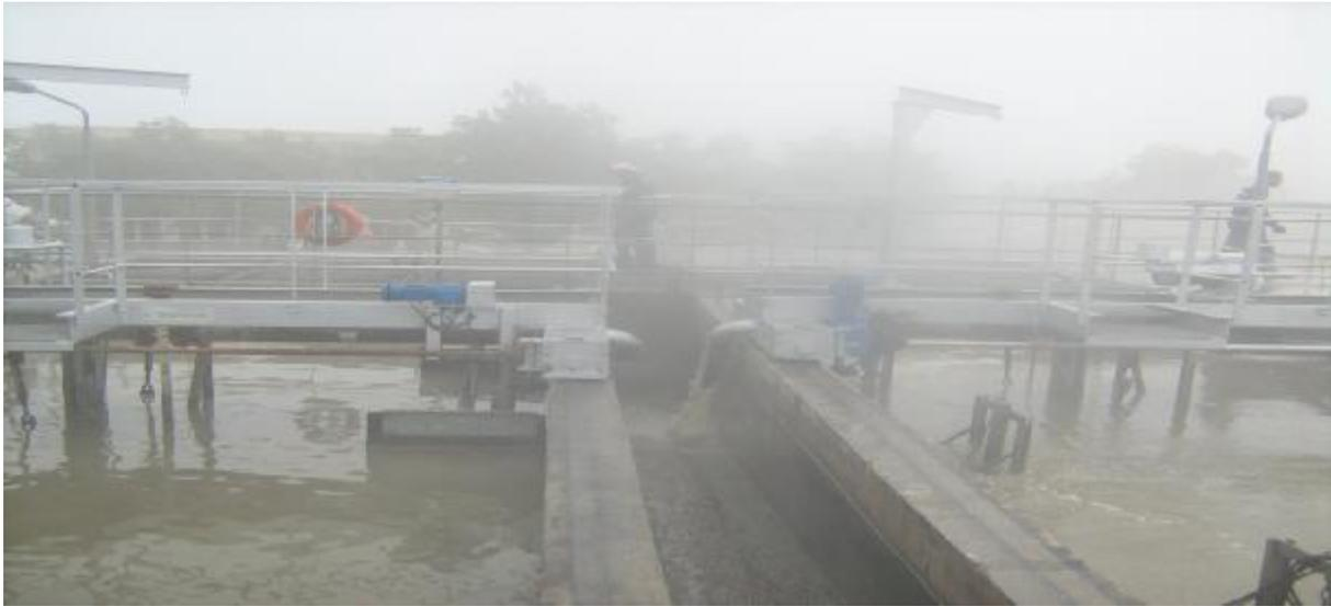
**Figure (I. 6): Le dégrillage et le dessablage .**
