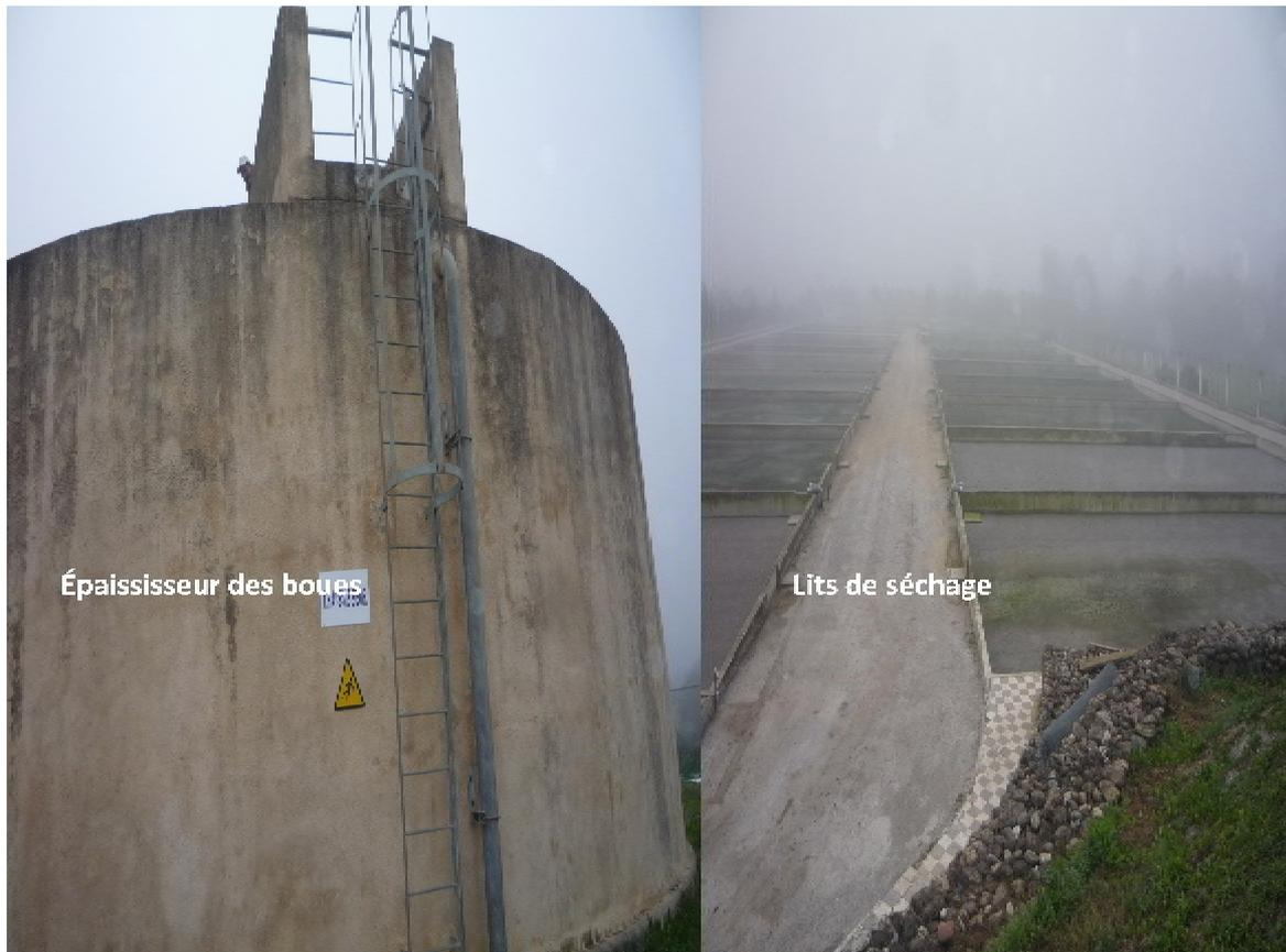
**Figure (I. 9) : Epaisseur des boues et lits de séchage.**
