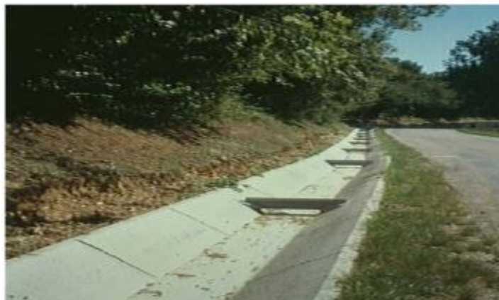
Figure01: Fossé béton armé
