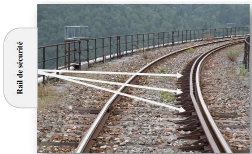
Figure11 : rail de sécurité.
