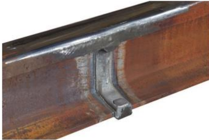
Figure 13 : technique de soudure des rails.
