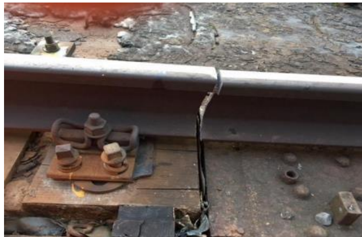
Figure09 : rail rompu
