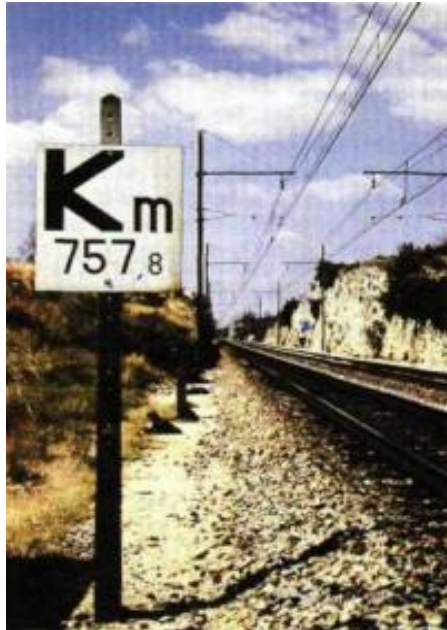
Figure06 : Pancarte (point de transition de la vitesse-limite d'une section de ligne).
