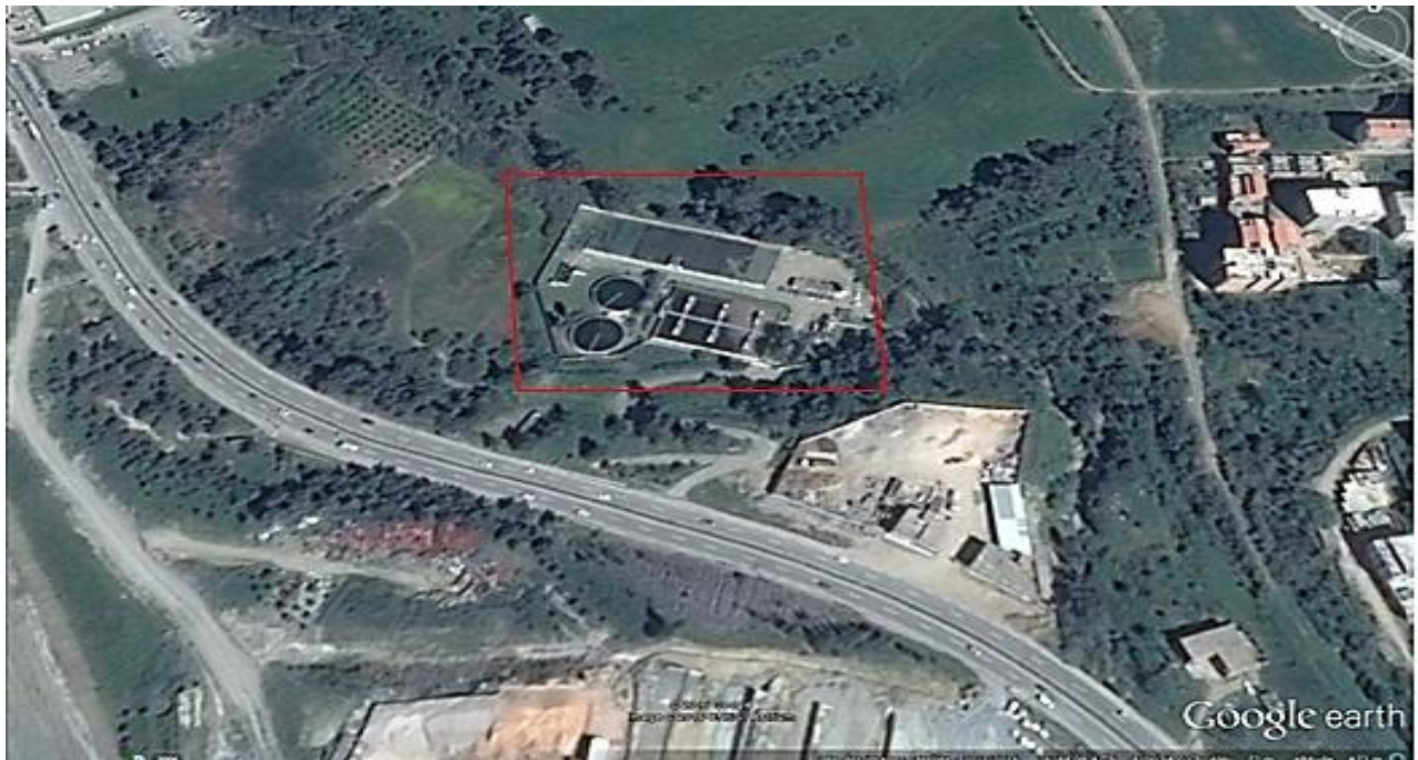
Figure N° 9: image satellite de la station d'épuration de boukhalfa.
