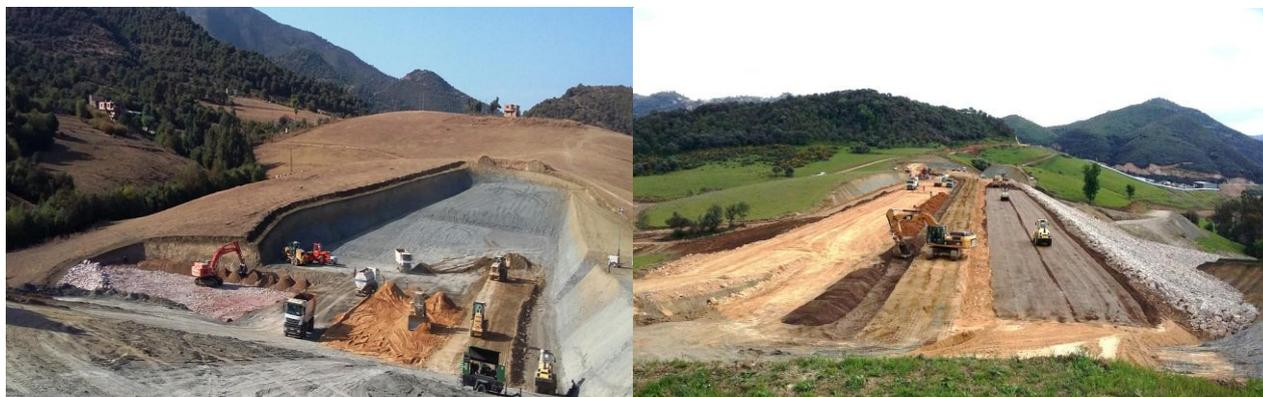
Photographie 7 : Excavation et remblaiement à la digue de col (TVC, Argiles, transition et enrochement)
