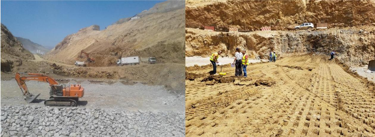
Photographie 9 : Vue du batardeau amont en enrochement et mise en place du noyau argileux de la digue sur la paroi moulée par compactage au rouleau « pied de mouton » (ici mesure de la densité au Gamma densimètre)
