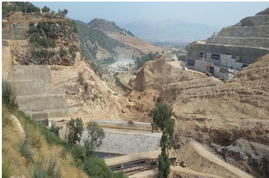
Photographie 12 : Vue du site de la digue principale en aval du batardeau amont (avec enrochement et noyau en argile, excavation du berceau de la digue principale au fond galerie d'injection en rive droite.
