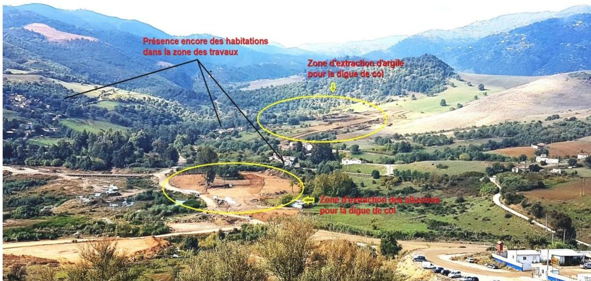
Photographie 2 : Une vue des carrières d'argiles utilisées pour la construction de la digue de col et principale. (ANBT)
