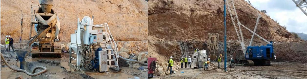
Photographie 11: Vues des engins d'excavation et de bétonnage de la Paroi-Moulée, avec tubes plongeurs et de pompage
