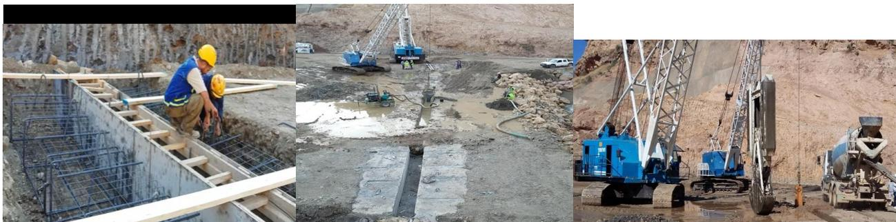
Photographie 10 : Réalisation des murs guide au niveau l'axe de la paroi moulée et remplissage des panneaux de bentonite.
