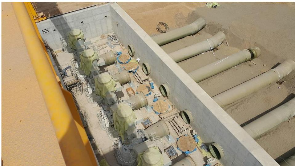
Figure 4 : Système d'aspiration d'eau de mer.[1]
