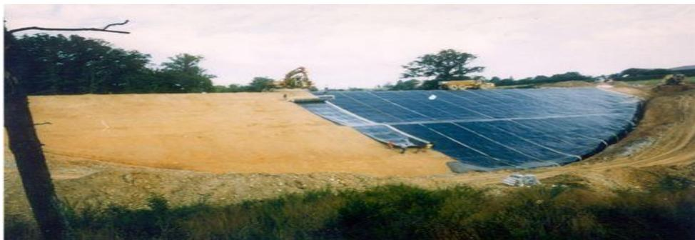
Figure 6.6 : Barrage à masque en membrane souple
