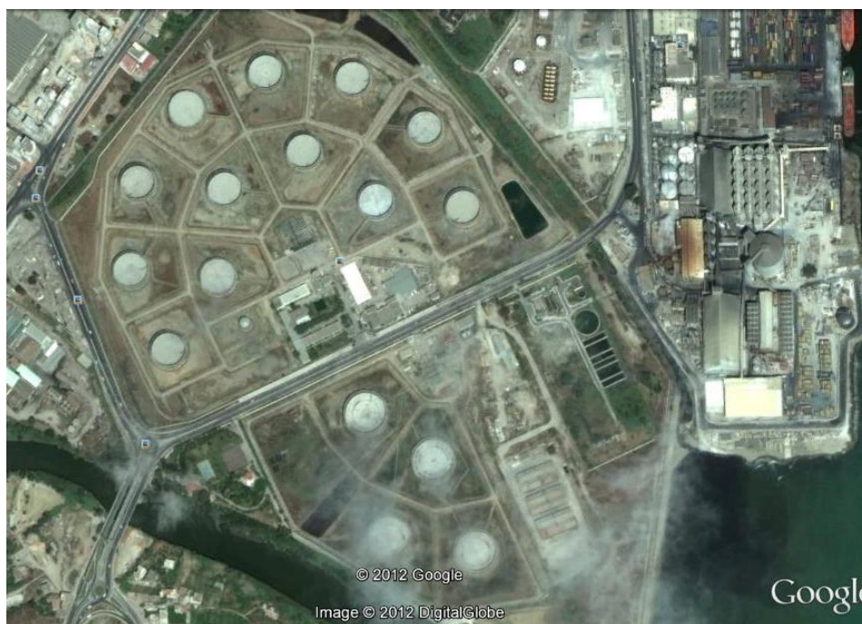
Figure 5 : Le terminal marin de Bejaia.[1]
