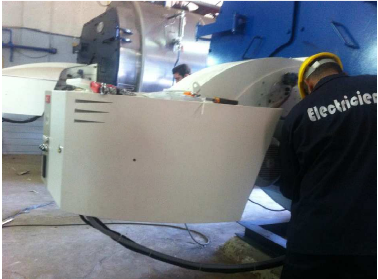
Figure II.12 : Installation de la chaudière MYRA4000 chez le client.
