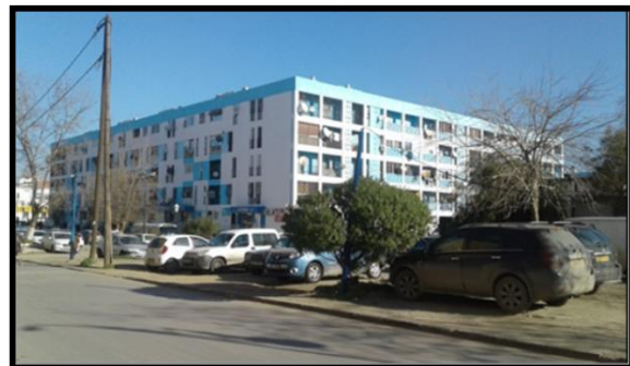
Figure 43 : cité d'habitat collectif, source : par auteur, 2018.
