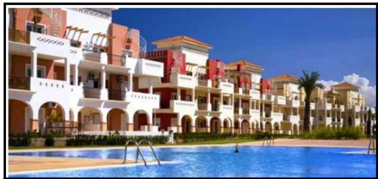
Figure262 : photo du complexe, source : Google image.
