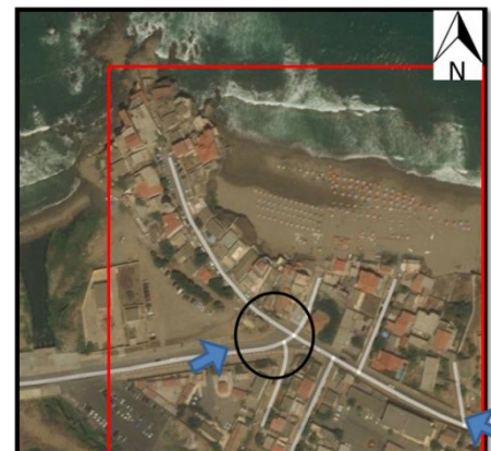
Figure 34 : la 1 ère sous-entité, source : Google earth, 2018, traitée par auteurs.
