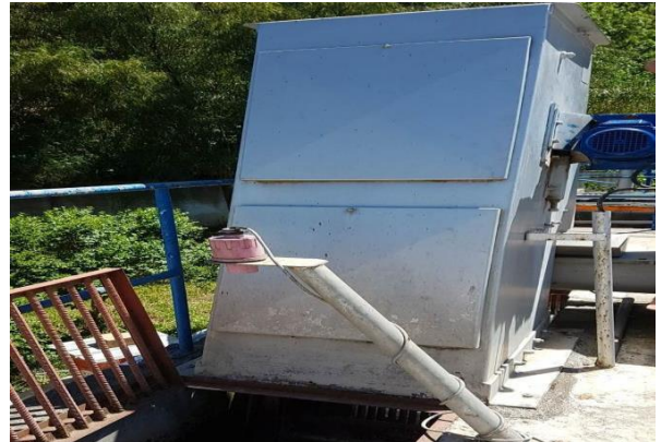
Figure 7 : Dégrilleur fin mécanique
