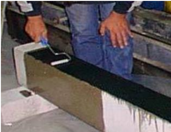
5. Mise en place, sans étirement, du tissu Sur le support béton
