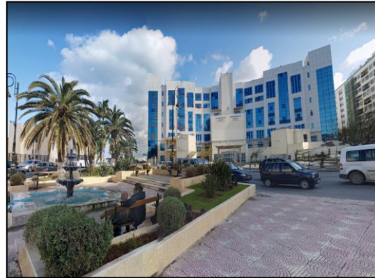
Figure II-117: Institut de musique Source : Auteur
