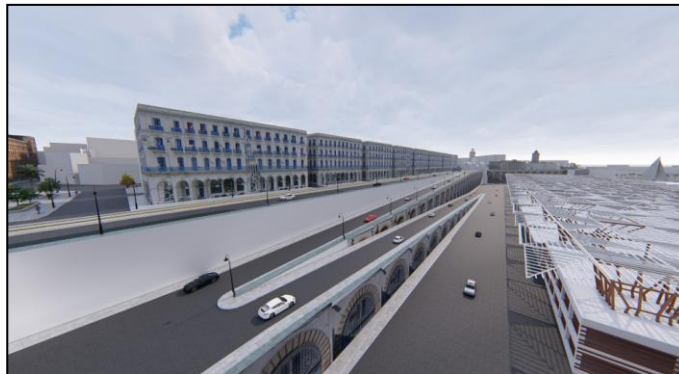
Figure III-65 : Vue sur les rampes Chassériau du boulevard du front de mer
