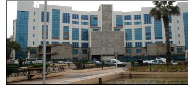
Figure II-30 : Institut de Musique Source : Auteur
