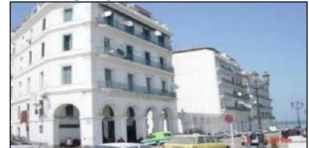
Figure II-34: Bâtiments coloniaux Source : photo prise par l'auteur
