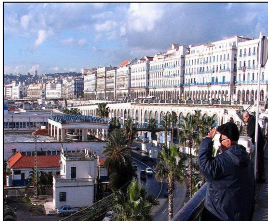
Figure II-111: Bâtiments haussmanniens Source : www.ladepeche.fr
