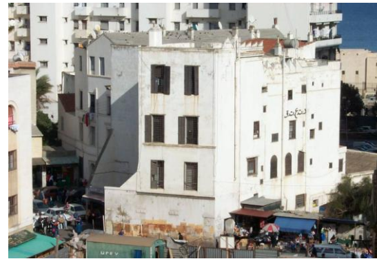
Figure II-105: Dar El Hamra Source : casbahdaleer.dz/elhamra.html
