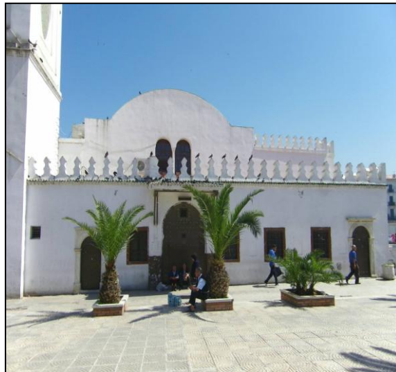
Figure II-98: L'entrée de l'édifice Source : archnet.org
