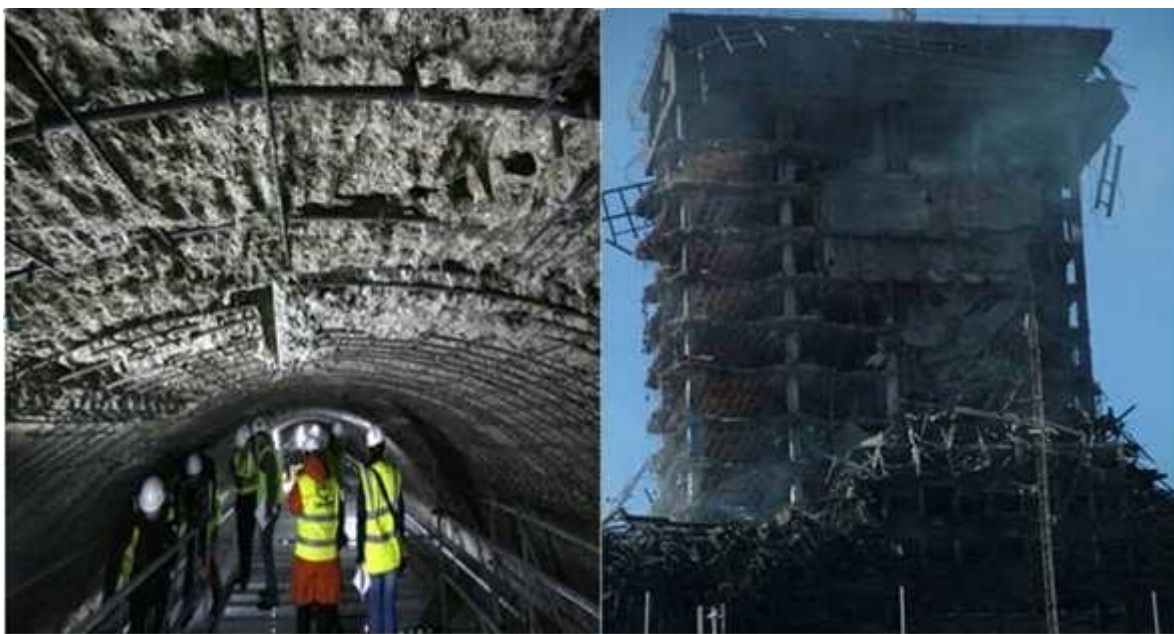
Tunnel Sous la Manche en phase de réparation à la suite de l'incendie de Septembre 2008, [1].
