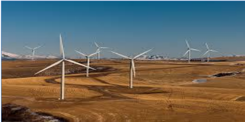
Fig. III.10 : Ferme éolienne On-Shore
