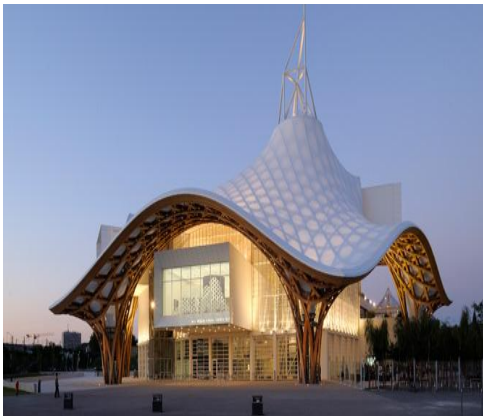
Figure 32 : Bâtiment à membrane et Toitures modernes [c8]
