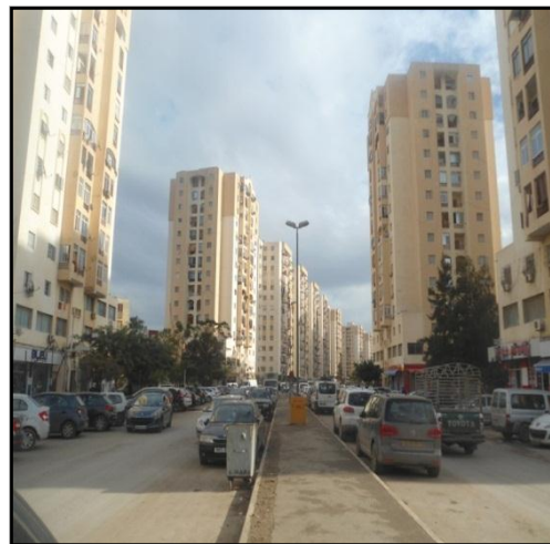
Figure I.18 : photo de l'entité résidentielle. Source : les auteurs.
