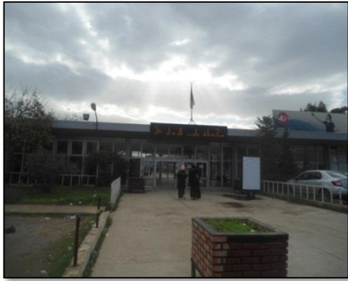
Figure II-28: Photos actuelle de la gare Source : les auteurs
