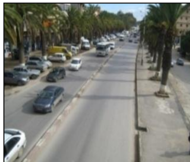
Figure I.9 : photo de la route nationale N°5 Source : les Auteurs
