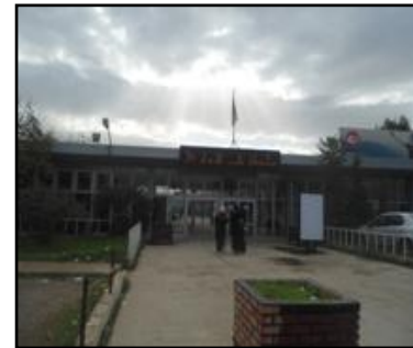
Figure 34 : photo de la gare ferroviaire. Source : les auteurs.
