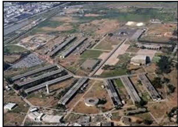
Figure II-72: Vue aérienne de l'USTHB Source: Http: //Google Earth.com
