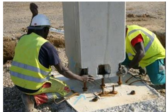
Figure III-35 : mise en place du poteau en béton armée préfabriqué
