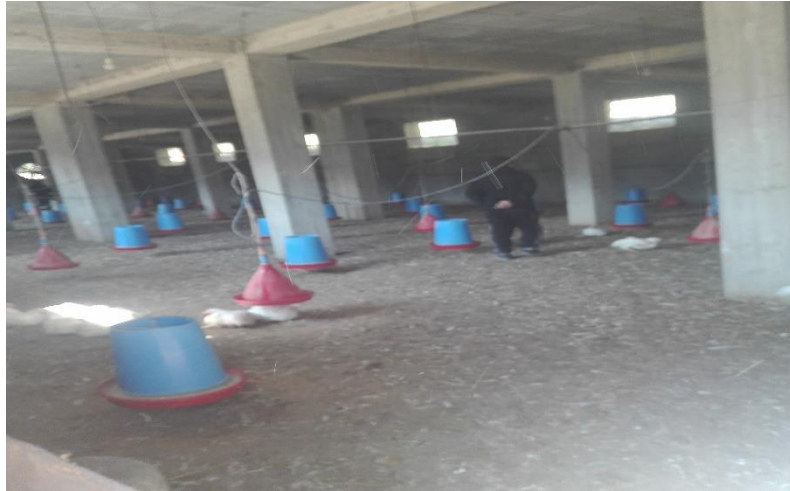
Figure 19 : exemple d'un sol en terre battue dans un bâtiment avicole à Beni Douala
