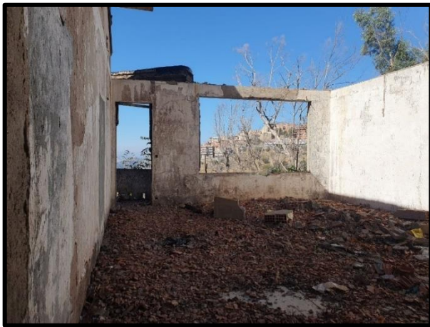
Photo 63 : Salle de classe. Source : Auteur.
