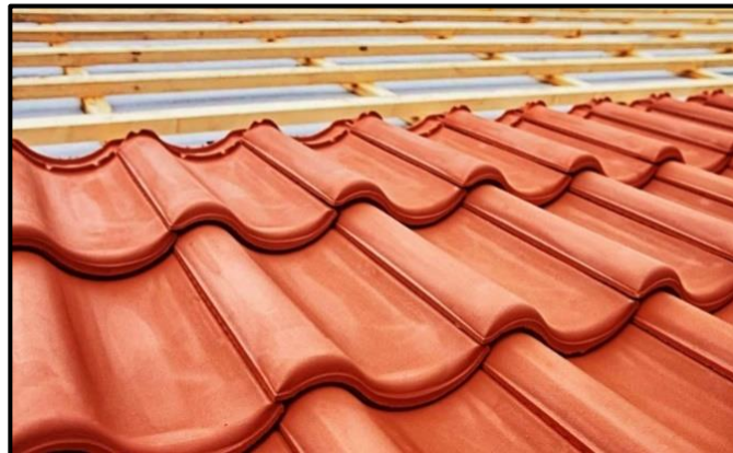
Photo 124: Vue sur la tuile mécanique. Source : Auteur.
