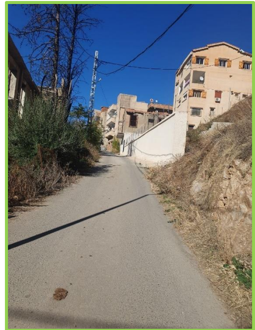
Photo 60: Vue sur la voie de 2eme hiérarchie.
