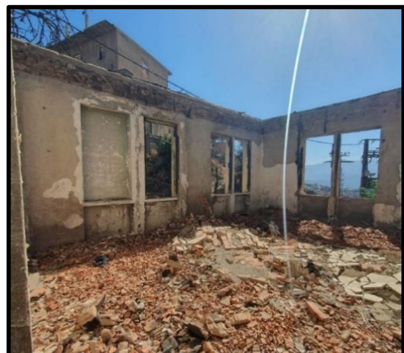
Photo 66 : Chambre Source : Auteur.
