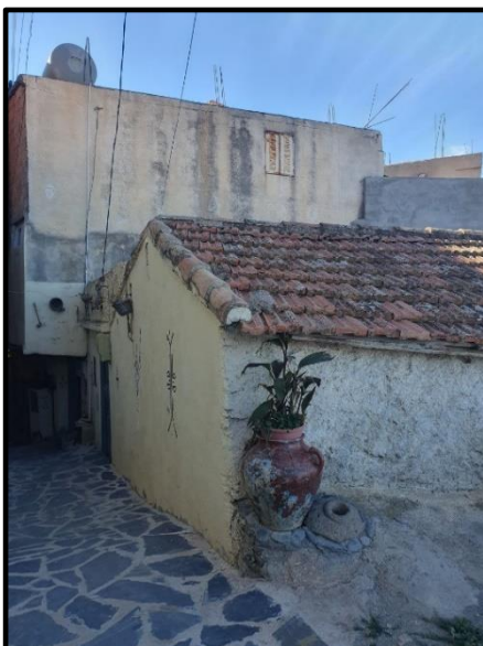
Photo 22: Vue sur tuile mécanique Source : Auteur.
