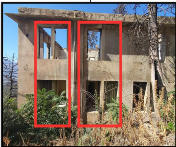
Photo 74 : Vue sur les fenêtres de la façade principale.
