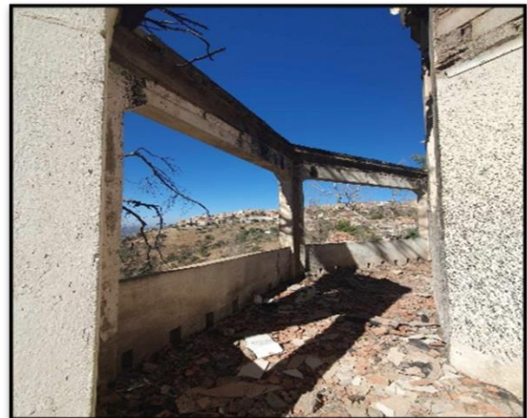
Photo 64: Galerie extérieure. Source : Auteur.
