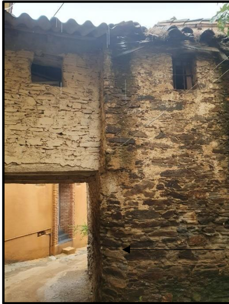
Photo 112: Askif. Source : Auteur.
