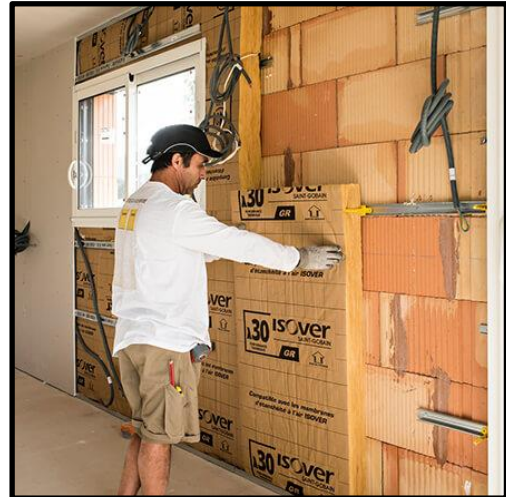
Figure 72: Mur isolés avec de la laine en verre Source : Google images.
