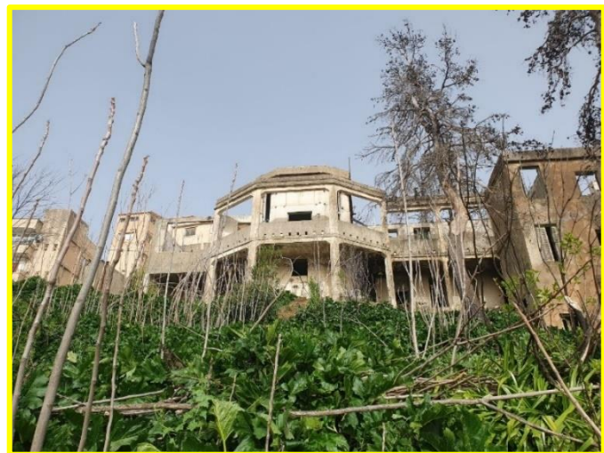
Photo 62: Vue sur le siège des sœurs blanches à partir de la ruelle.
