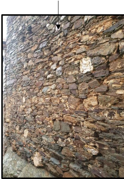
Photo 24: Vue sur un mur en pierre.
