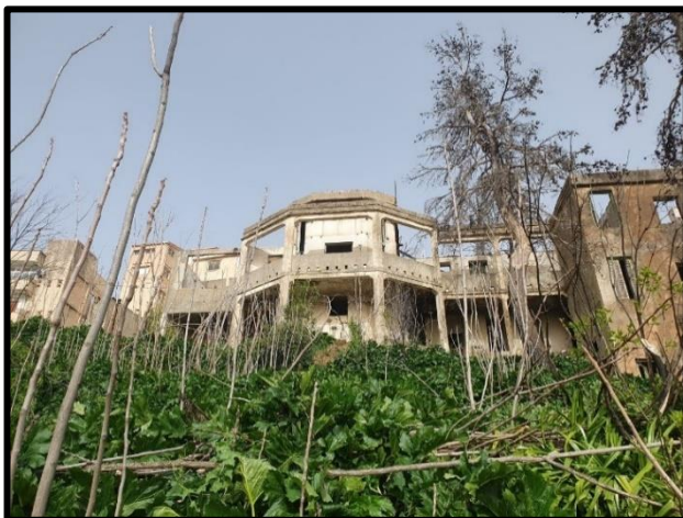
Photo 76 : Vue sur la façade postérieure. Source : Auteur.
