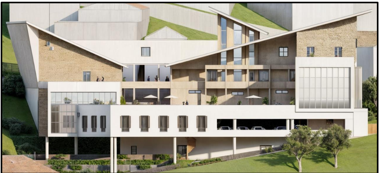
Photo 121: Façade postérieure. Source : Auteur.
