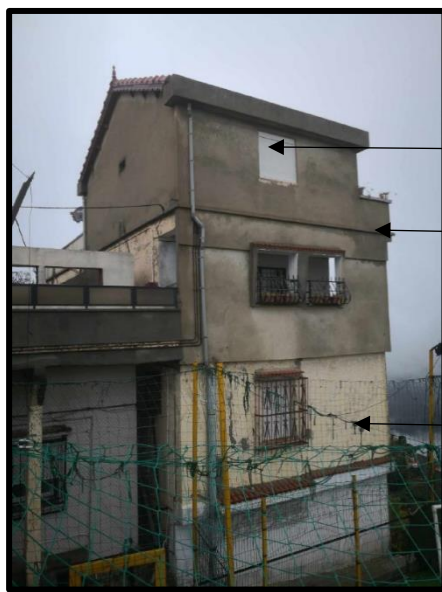
Photo 29: Vue sur une nouvelle construction érigée sur l'ancienne construction. Source : Auteur.
