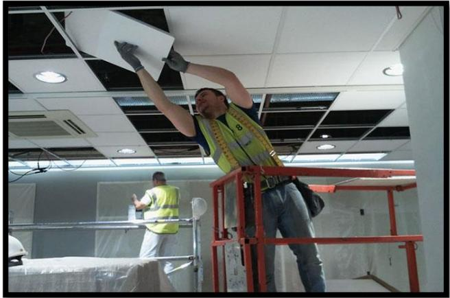
Figure 129 Mise en œuvre des faux plafonds
