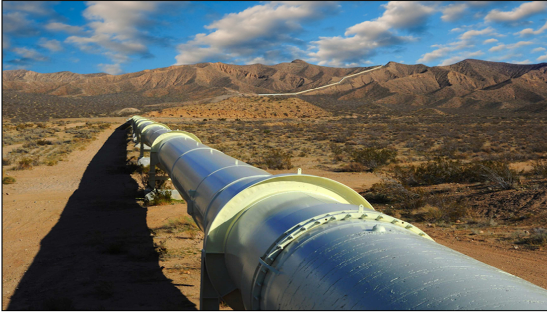
Figure I.5. Les pipelines (oléoducs).
