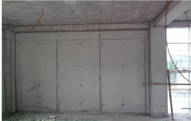
Figure I-2: Voile en béton armé
