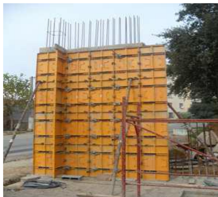
Figure I-5: coffrage métallique
