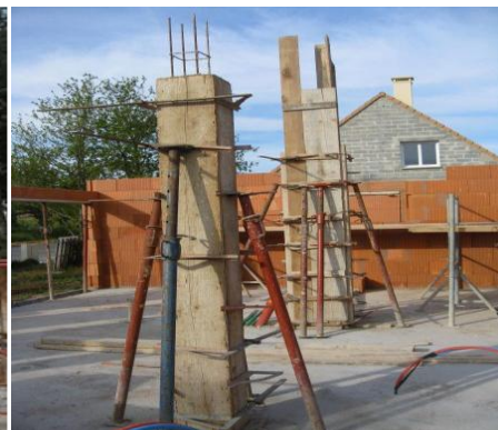
Figure I-6: Coffrage en bois
