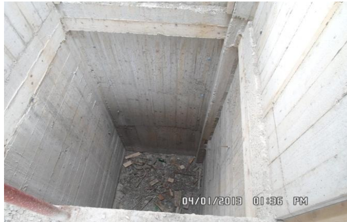
Figure I-4: Cage d'ascenseur en voiles
