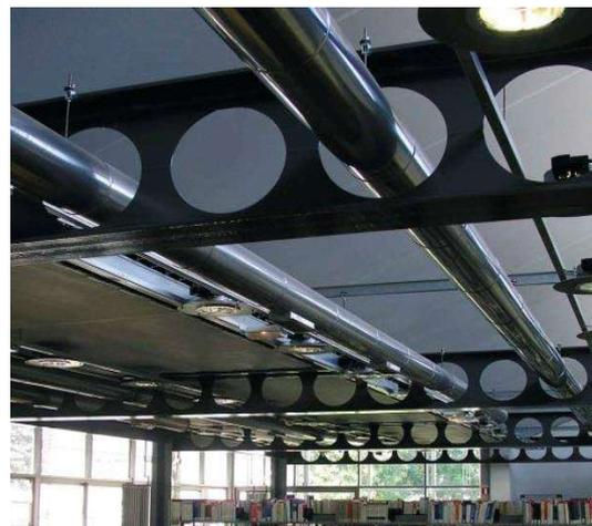
Figure 138 : poutre alvéolaire
