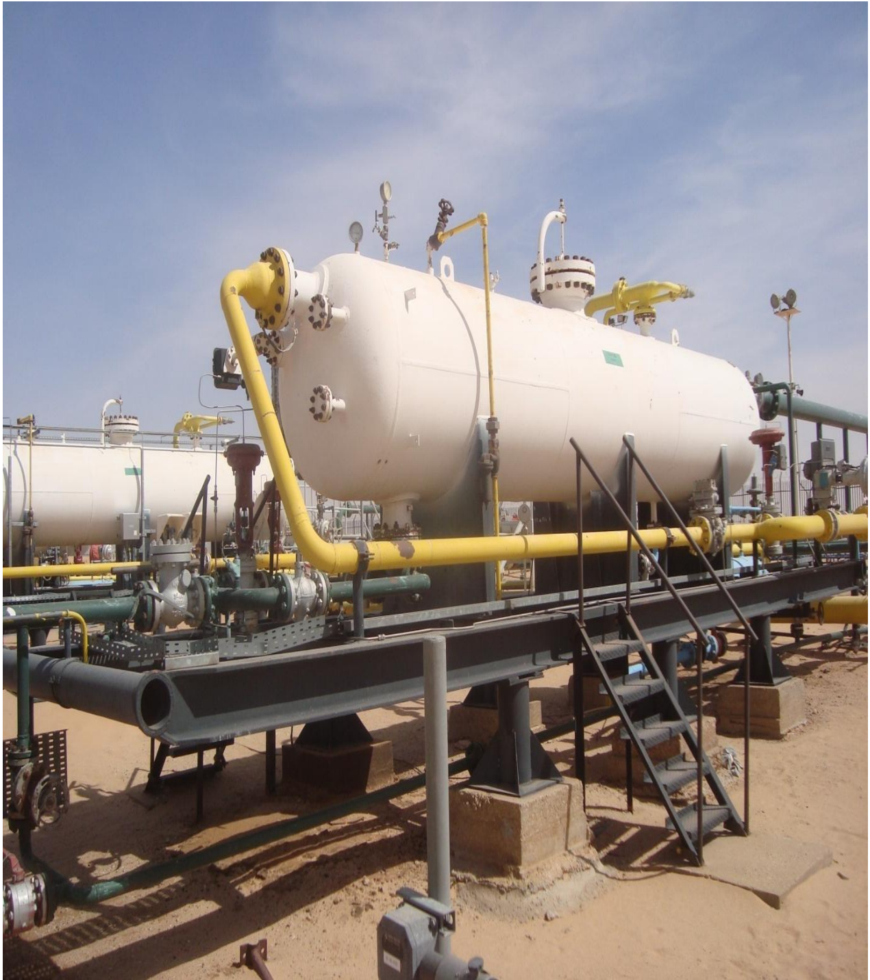
Figure II.5 : Vue générale du séparateur 10-V-120.
