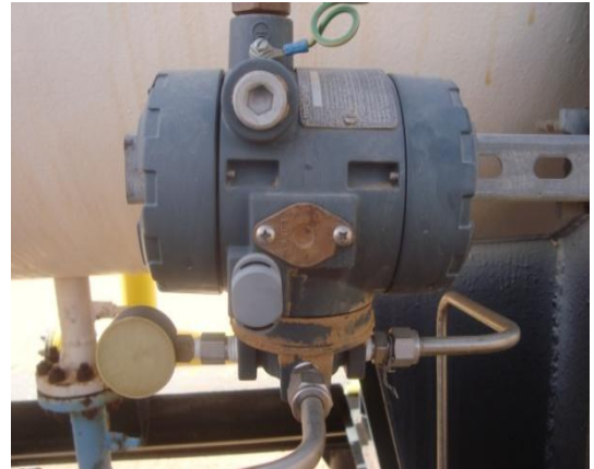
Figure III.8 : Convertisseur I/P.
