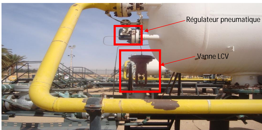
Figure II.6 : La vanne LCV avec le regulateur pneumatique.
