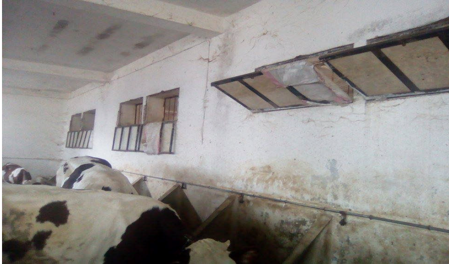
Figure N° 24: Fenêtres du bâtiment d'élevage.
