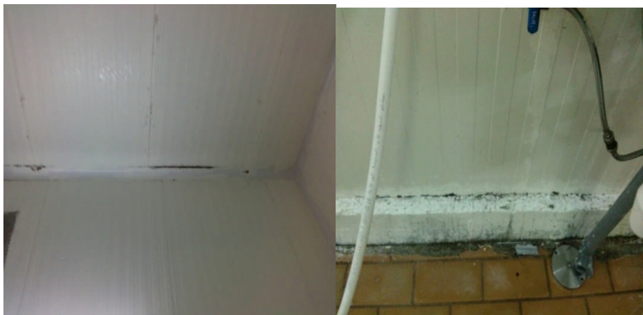
Figure N°33 : Jonctions des surfaces.
