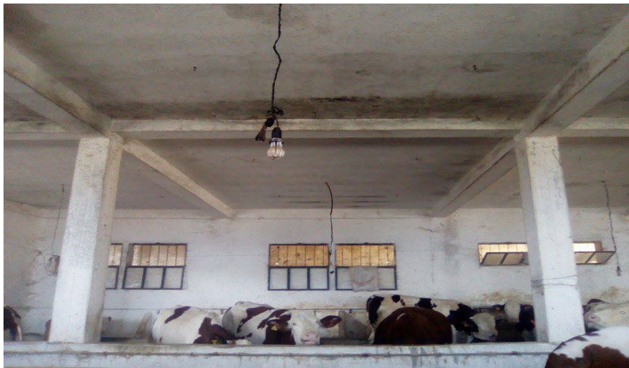
Figure N° 25 : Dispositif d'éclairage du bâtiment d'élevage.
