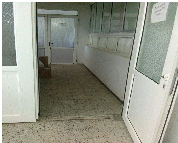
Figure N° 34 : SAS du laboratoire.
