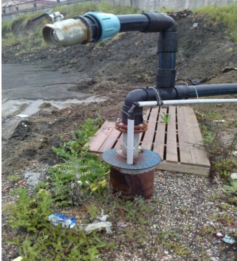
Figure N° 35 : Forage de l'eau.
