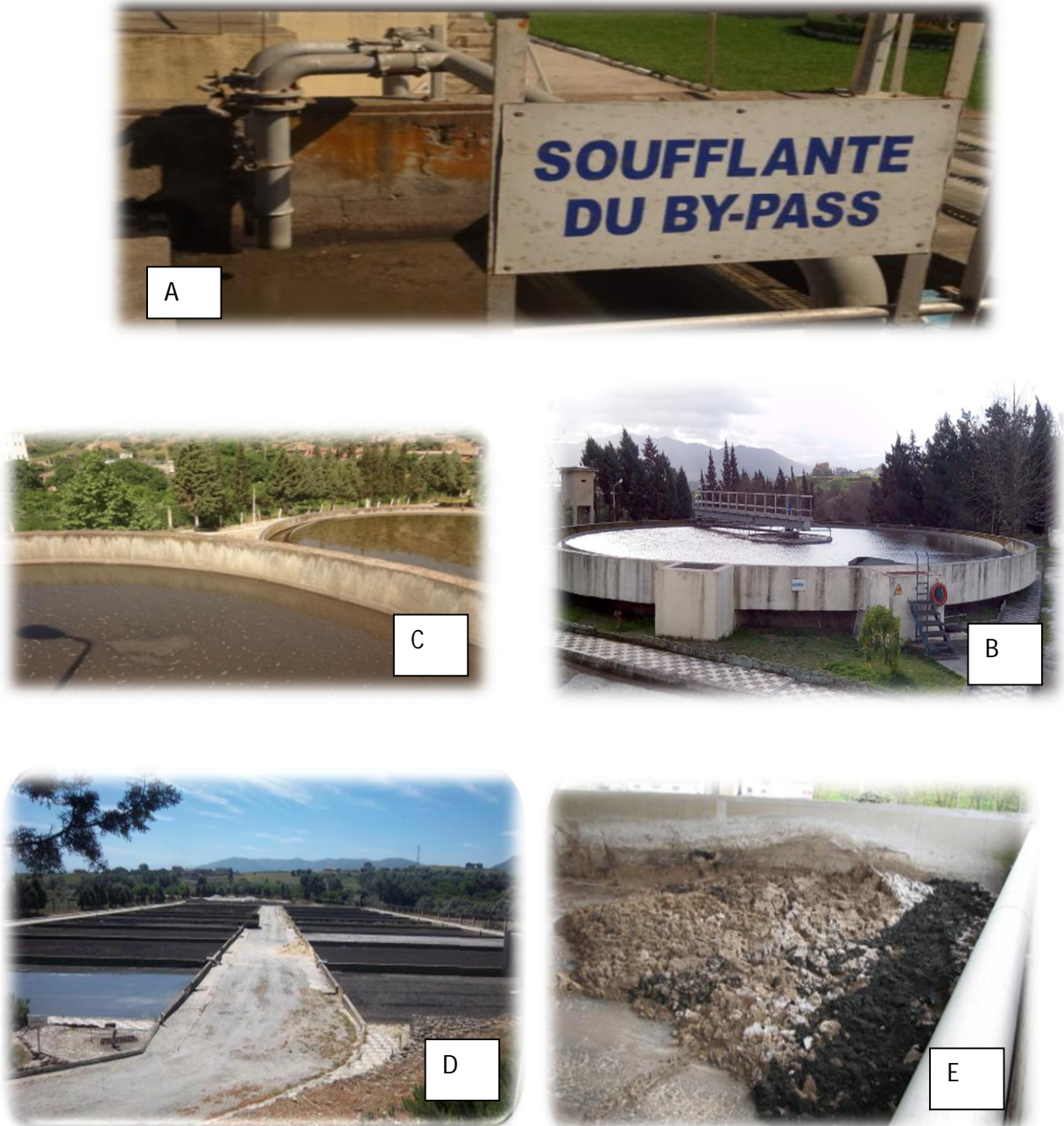
Figure 7 : Représente les étapes d'épuration des eaux usées.
