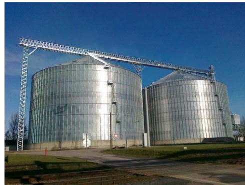
figure N°17 : représente les silos métalliques
