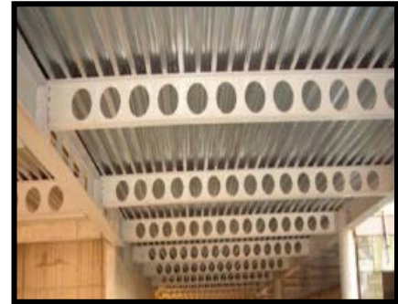
Fig.50. Plancher collaborant sur poutres alvéolaires.
