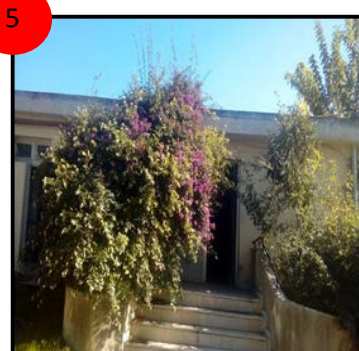
Fig.10. atelier de l'entreprise Source: auteurs
