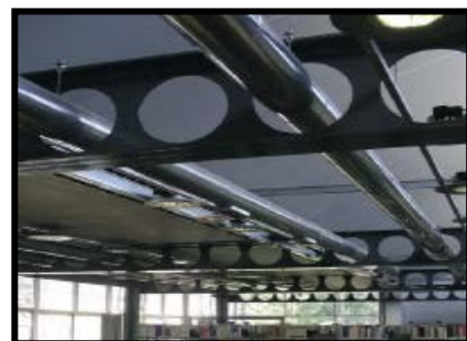
Fig.48. Poutres alvéolaires IPN
