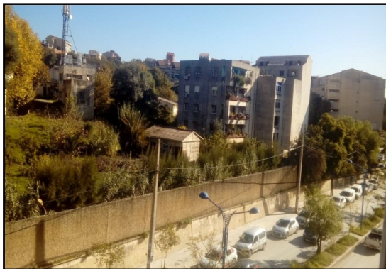
Fig.25. l'assiette d'intervention vue depuis l'immeuble d'en face Source : l'étudiante salemi
