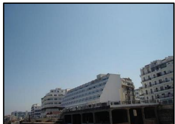
Figure 49 : hôtel kittani source : photo prise par les auteurs
