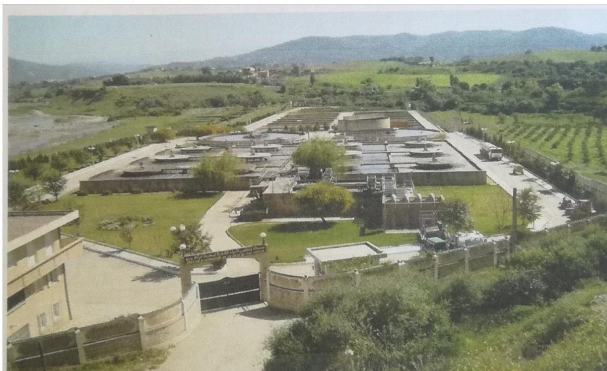
Figure 09: Image de la STEP Est de pont de bougie (Tizi Ouzou)
