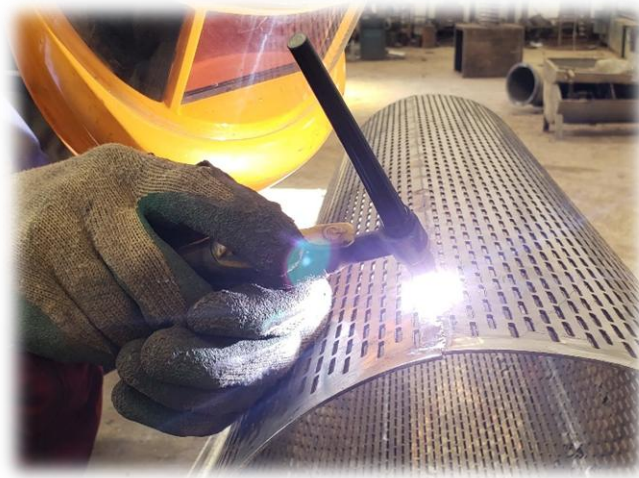
Figure III-6 : L'opération de soudage
