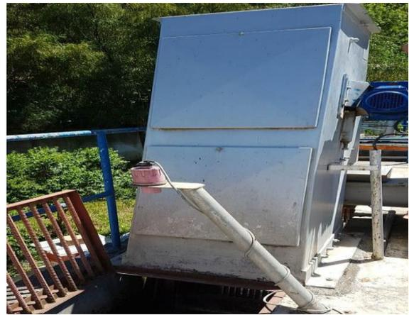
Figure 4 : Dégrilleur fin mécanique.
