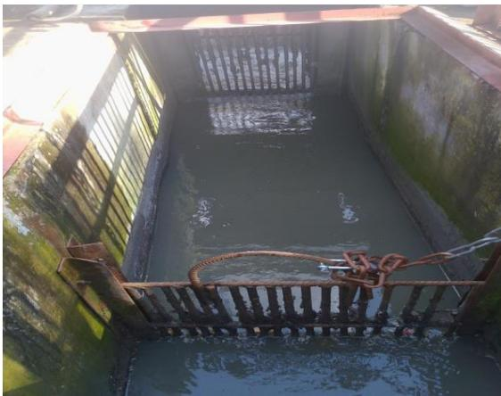
Figure 3 : Dégrilleur fin manuel.
