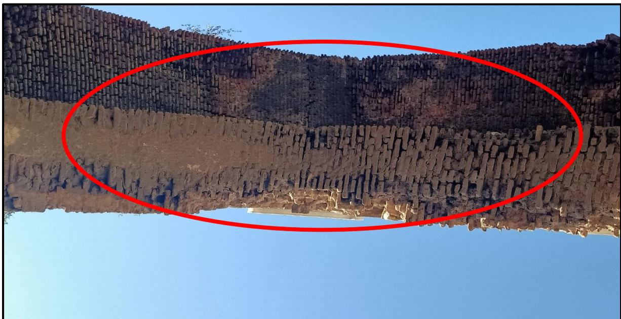
**Figure 75** : Altération de brique au niveau de la partie supérieure du premier arc.
