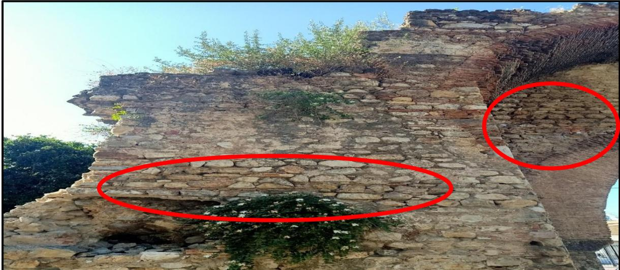
**Figure 72 :** Eventrement de la maçonnerie
