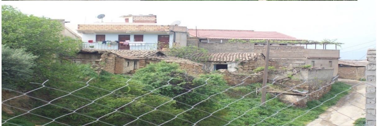
Image N°7 : Maisons traditionnelles et rénovées
