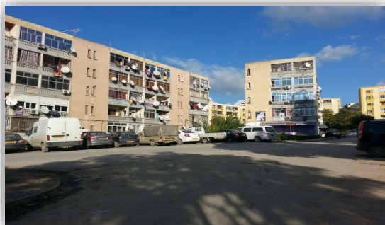
Fig.97. Façades Avant la réhabilitation Source : prise par auteurs.
