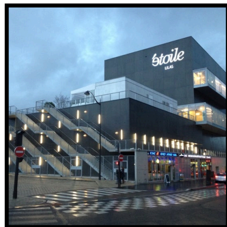
Figure 151: vue sur la façade de la salle étoile de lilas Source : www.google.image.fr .
