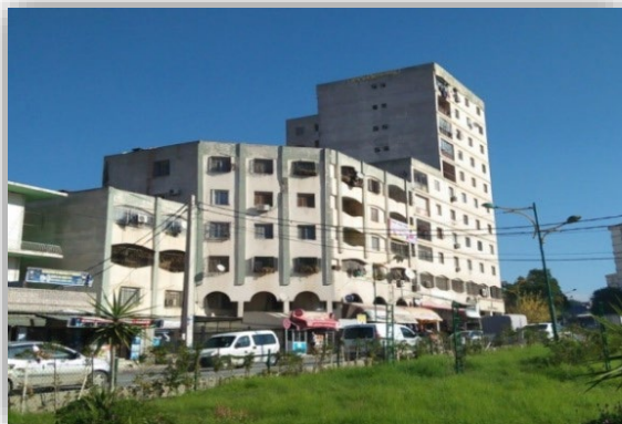
Fig.100. Façades Avant la réhabilitation Source : prise par auteurs.
