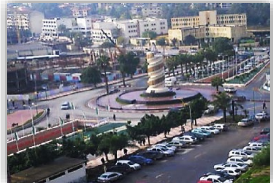
Fig.32. deuxième tronçon source : Google
