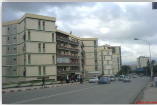
Fig.103. Façades Avant la réhabilitation Source : prise par auteurs.
