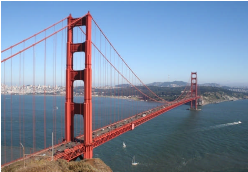
Figure 1-4: Pont du Golden Gate, San-Francisco ; Californie ; Longueur totale : 2737 m ; Portée principale: 1280 m ; Hauteur: 230 m ;
