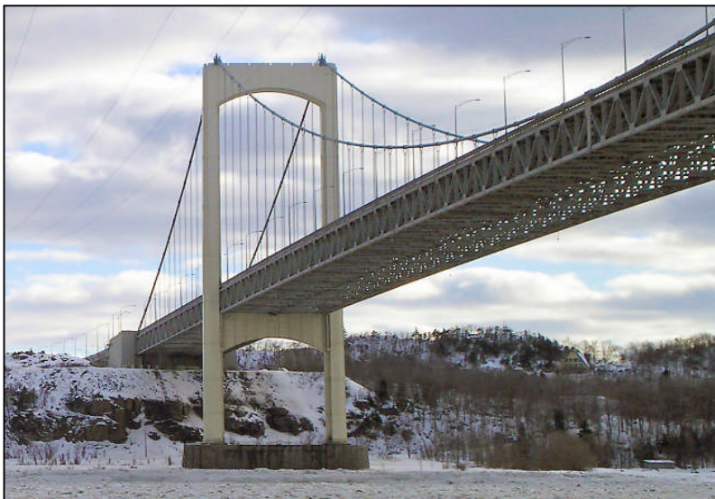
Figure1- 3: Pont routier Pierre-Laporte, Québec city ; Longueur totale : 1041 m ; Portée principale: 668 m ; Hauteur totale: 116 m ; Année : 1966-1970
