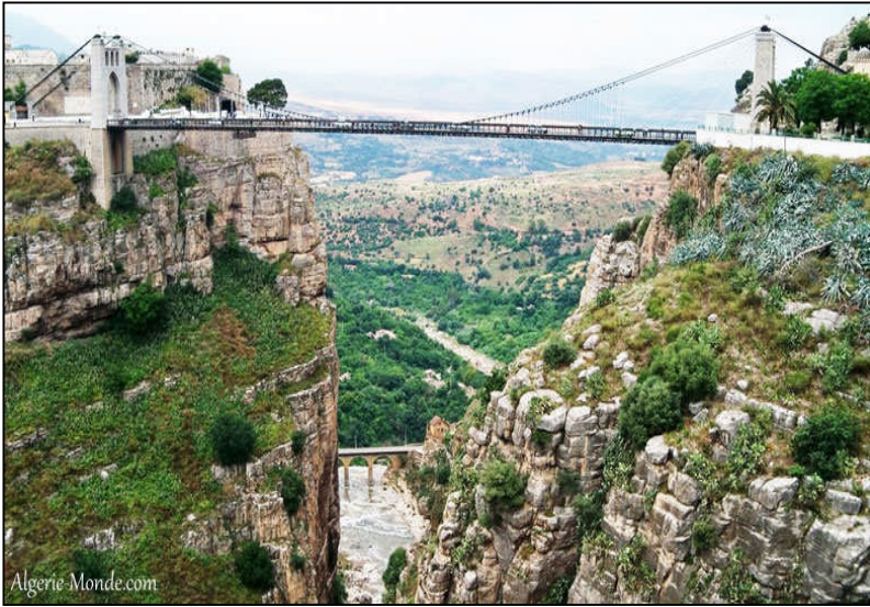
Figure 1-2: Pont Sidi M'Cid de Constantine surplombant les gorges à 175 m de Rhumel ; Année : 1910-1912 ; Longueur : 164 m ; Largeur : 5.75 m
