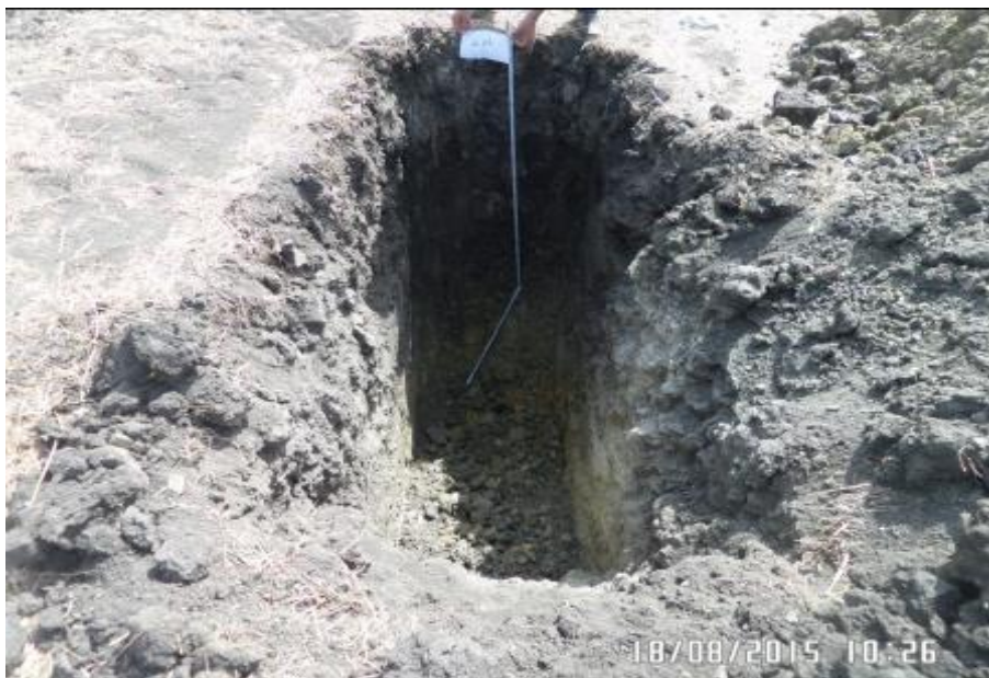
Figure III.1 : Puits n° 01 au PK 03+140.
