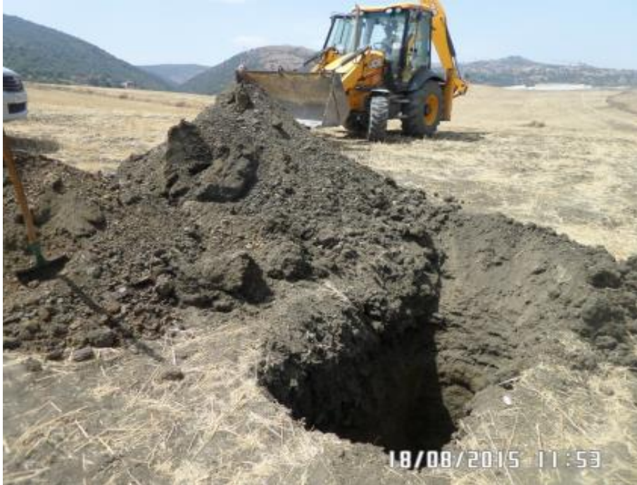
Figure III.4 : Puits n° 04 au PK 06+140.
