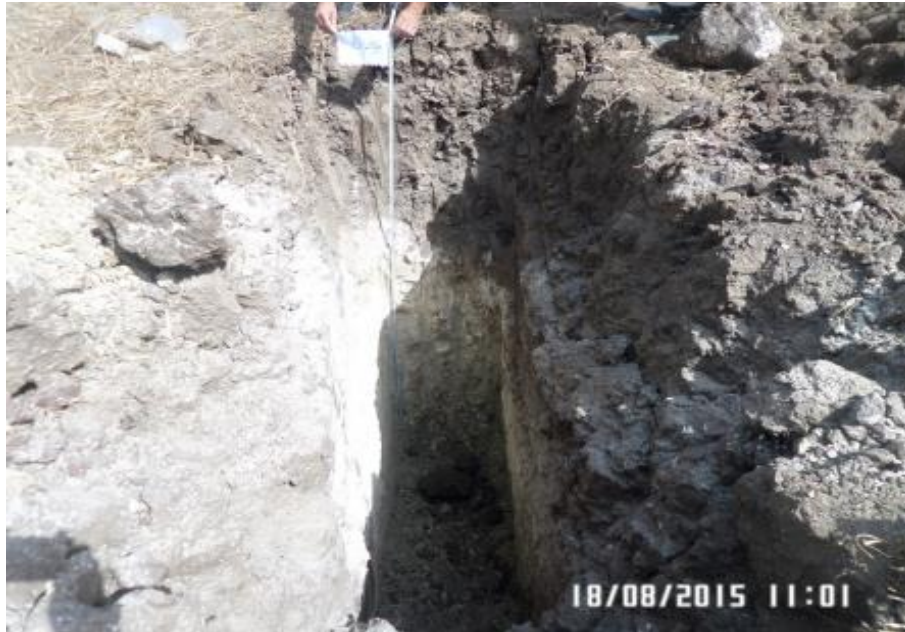
Figure III.2 : Puits n° 02 au PK 04+200.
