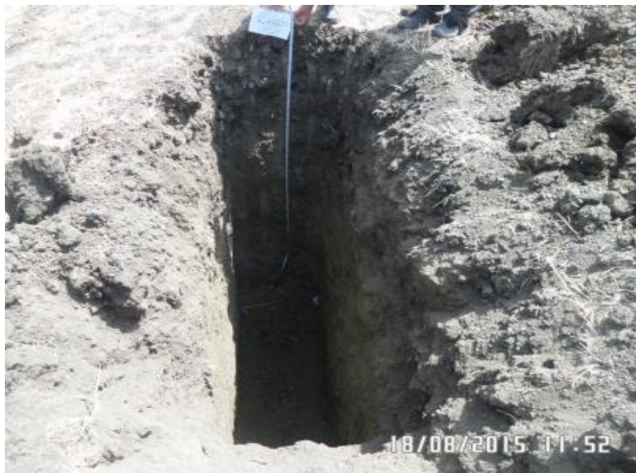
Figure III.3 : Puits n° 03 au PK 05+220.
