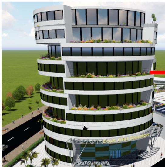
Figure74 : détail d'une terrasse jardin
