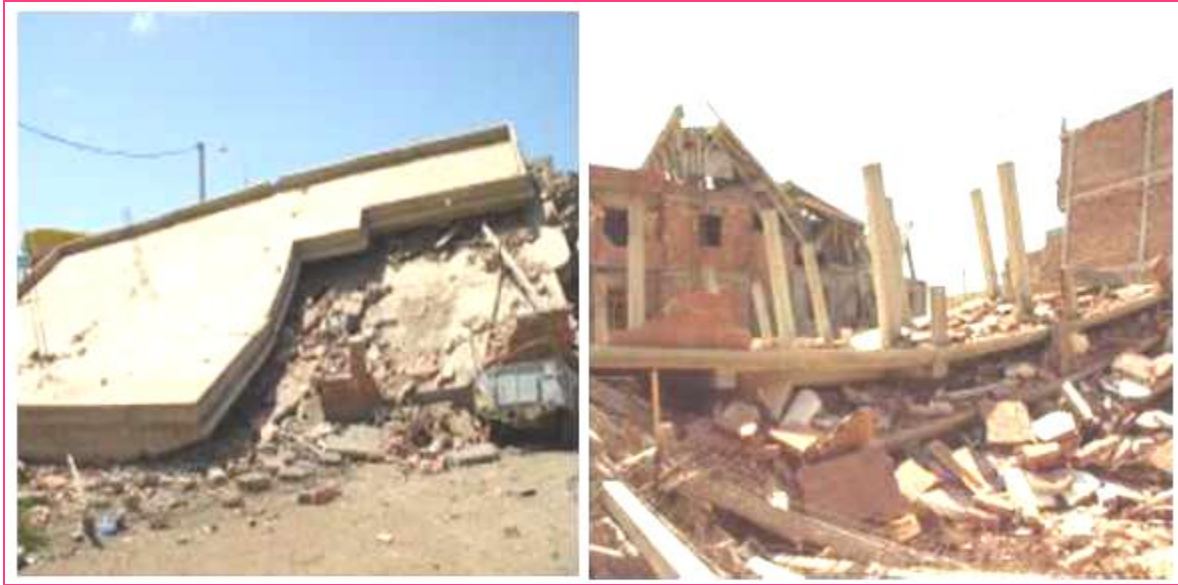
Figure I.6 Désolidarisation global des constructions [6]
