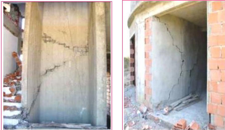
Figure I.18 Comportement des voiles
