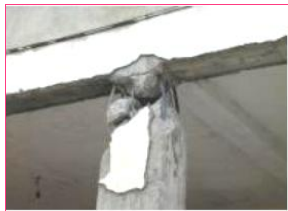
Figure I.8 Dislocation des sections des poteaux, poutres
