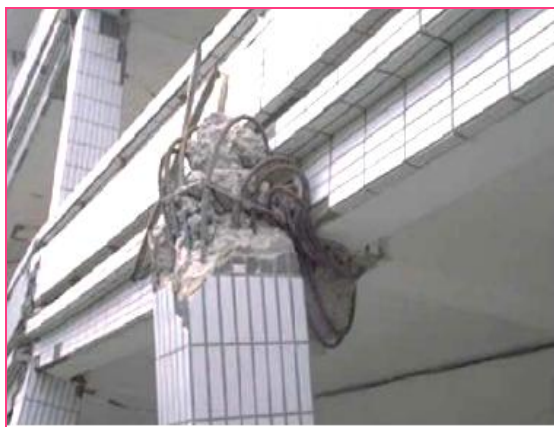
Figure I.7 Éclatement de zones critiques, extrémités
