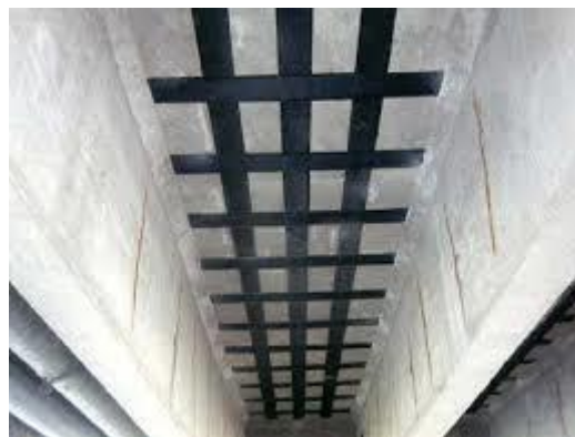
Figure I.11 : Renforcement d'une dalle de pont [3]
