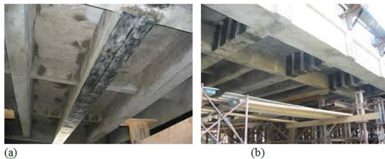
Figure I.12 : Réhabilitation du Banc d'El Harrach, Alger (photo CTC\Est) a) Renforcement en flexion, b) Renforcement en cisaillement
