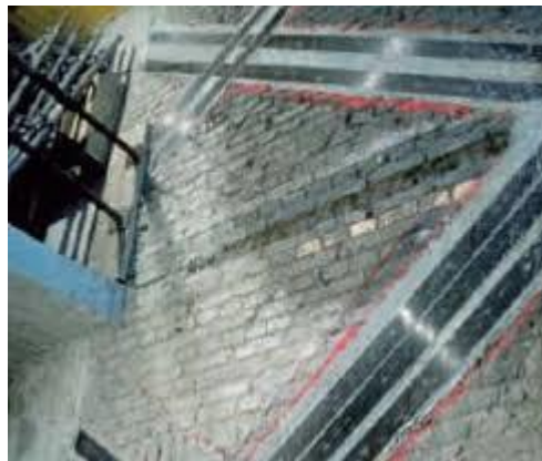
Figure I.10 : Réhabilitation d'un mur en maçonnerie (Suisse) [26]
