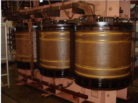
Fig.IV.1 Partie active – côté MT (secondaire)
