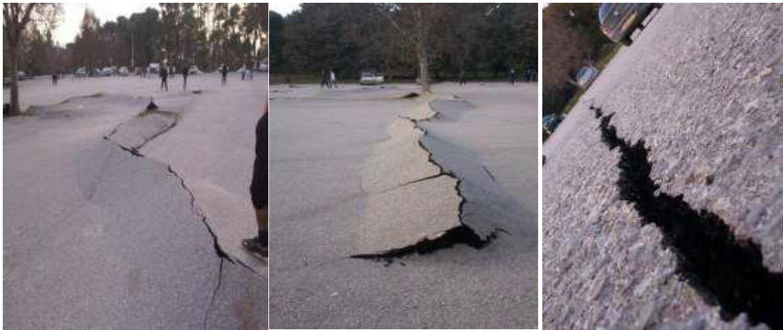
Figure IV.3. L'état de lieux de l'ouvrage après l'effondrement (soulèvement de sol au-dessus de tunnel)
