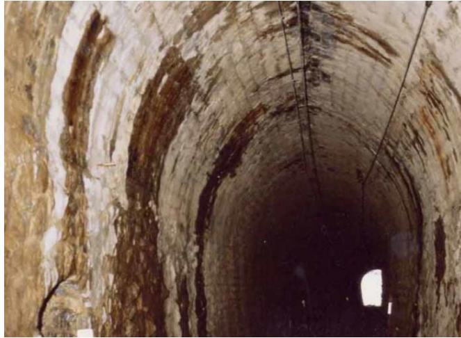
Figure II.17. Écaillage aux points d'inflexion de la déformation
