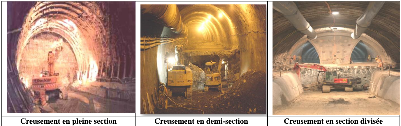
Figure III.4. L'excavation pour NATM suivant différents modes d'attaque
