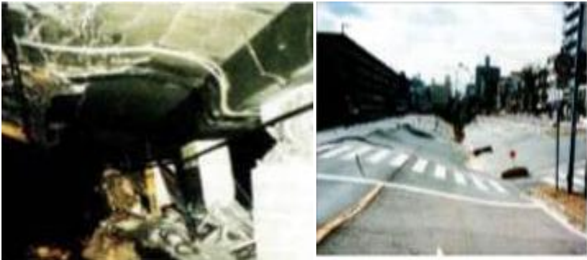
Figure II.1. Effondrement de la route nationale au-dessus de station de métro de Daika endommagée par un tremblement de terre en Japon (1995).
