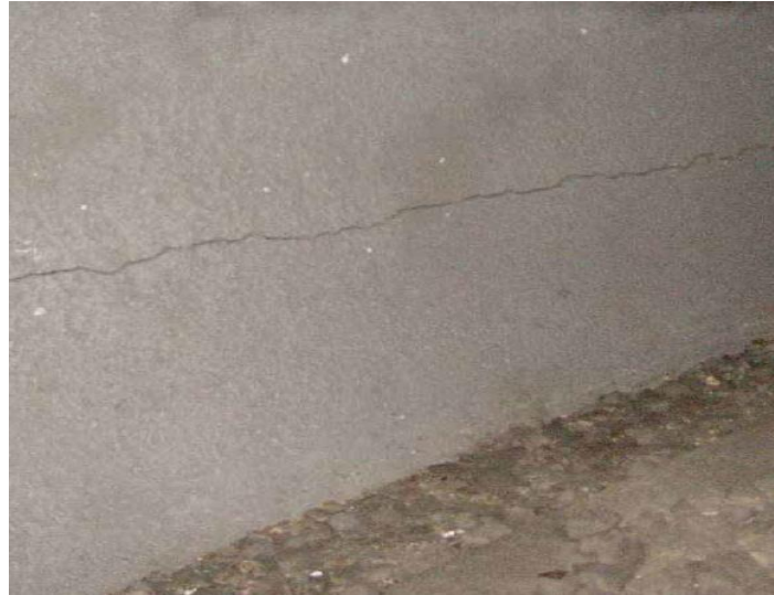
Figure II.13. Fissures longitudinales
