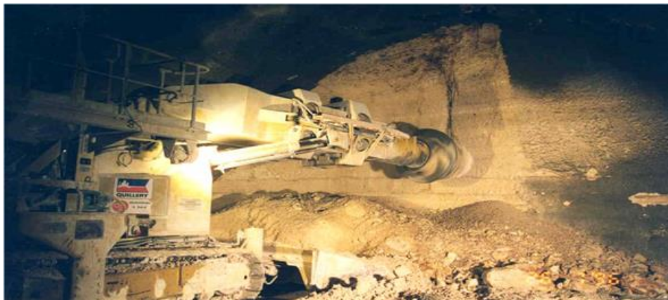
Figure III.2. Machine à attaque ponctuelle sur le tunnel de Tartaignille.
