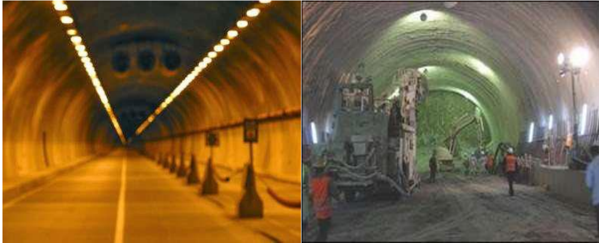
Figure IV.1. L'état de lieu de l'ouvrage avant l'effondrement
