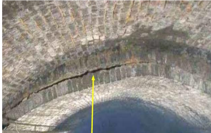
Figure II.10. Extrusion et effritement de la surface du joint sous l'action des efforts de compression en clé de voûte
