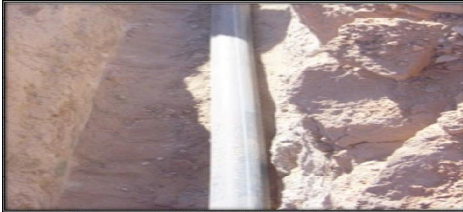
Figure VII.1 : Pose des conduites en terre
